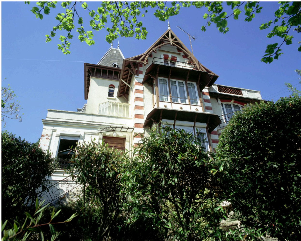
Vue partielle de la façade principale.
