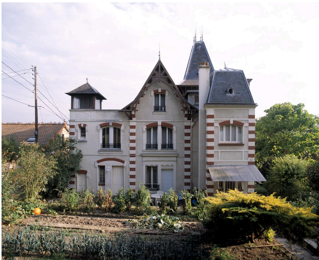
Vue de la façade arrière, sur la sente de la Fontaine Garelle.
