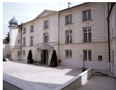
Façade antérieure après rénovation. Phot. Stéphane Asseline IVR11_20059400271VA
