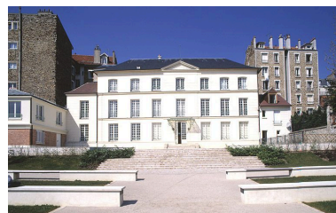
Façade postérieure après rénovation. Phot. Stéphane Asseline IVR11_20049400014XA
