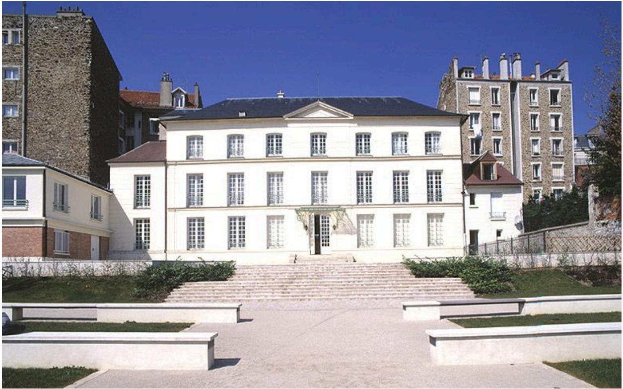
Façade postérieure après rénovation.
