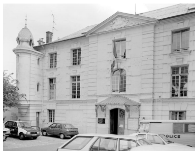
Façade antérieure. Phot. Christian Décamps IVR11_19869400395V
