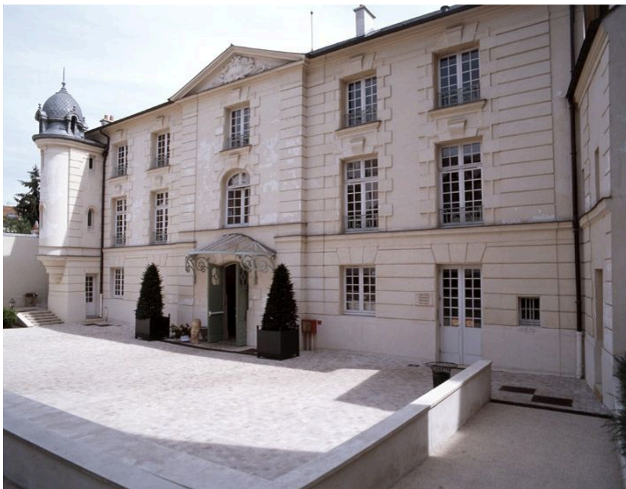
Façade antérieure après rénovation.
