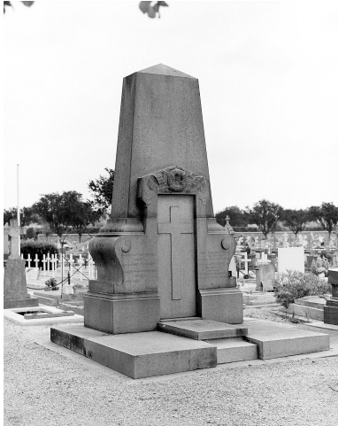
Vue d'ensemble. Phot. Philippe Ayrault IVR11_20019100279X
