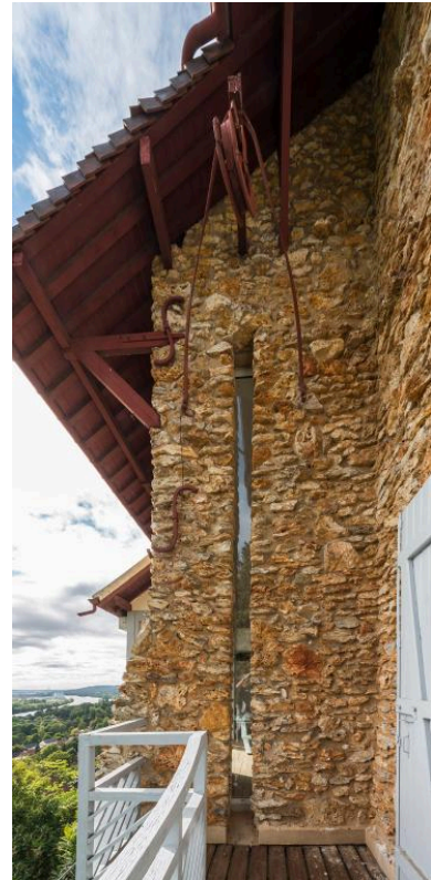
Fente dans la façade pour le passage des toiles Phot. Laurent Kruszyk IVR11_20197800265NUC4A
