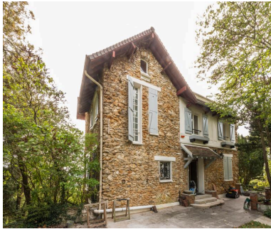
Vue générale de la maison Phot. Laurent Kruszyk IVR11_20197800263NUC4A
