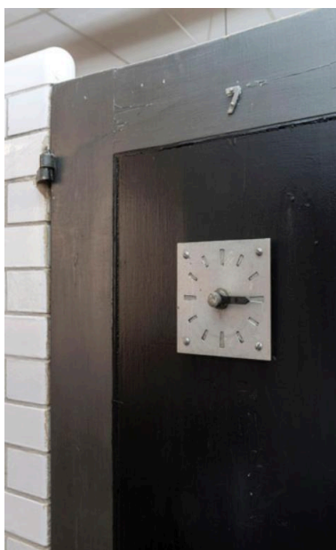
Horloge en fer, sur l'une des portes d'une ancienne cabine de bain-douche, permettant d'indiquer le temps restant à l'utilisateur. Chaque passage était limité à 20 mn. Phot. Laurent Kruszyk IVR11_20177500106NUC4A
