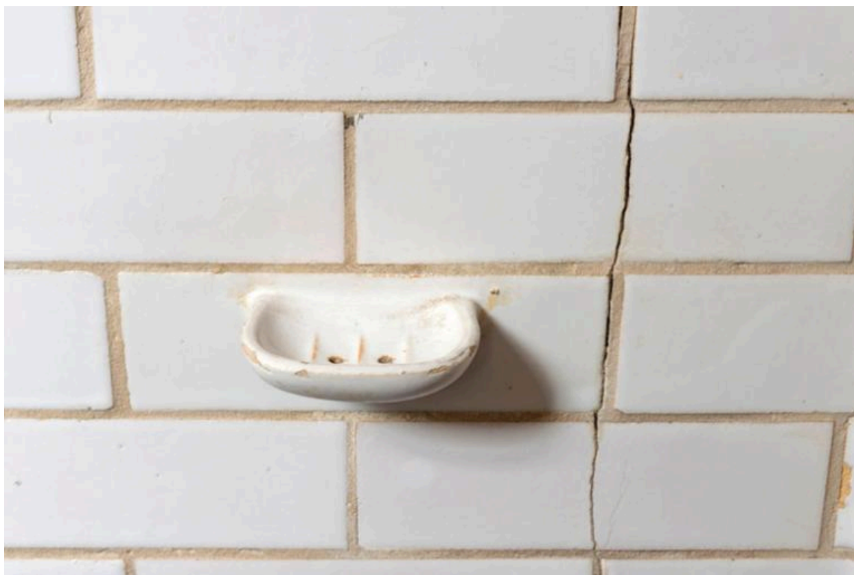
Porte-savon en forme de coquille dans une cabine de bain-douche.
