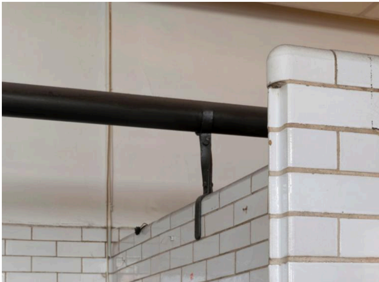
Détail du système de chauffage des douches (tuyau en zinc courant à la base du plafond, destiné à éviter les effets de condensation de l'humidité dans l'air).
