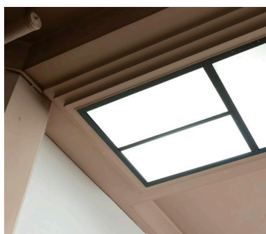
L'éclairage zénithal de la cage d'escalier. Phot. Laurent Kruszyk IVR11_20177500069NUC4A
