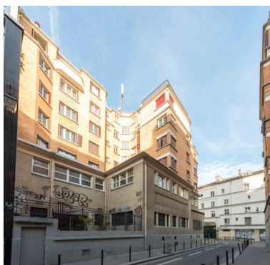
Élévation des bains-douches du côté du passage des Marais, avec la petite courette de service permettant d'accéder au sous-sol (chaufferie, réserve de combustible, salle des commandes).
