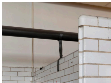
Détail du système de chauffage des douches (tuyau en zinc courant à la base du plafond, destiné à éviter les effets de condensation de l'humidité dans l'air). Phot. Laurent Kruszyk IVR11_20177500111NUC4A
