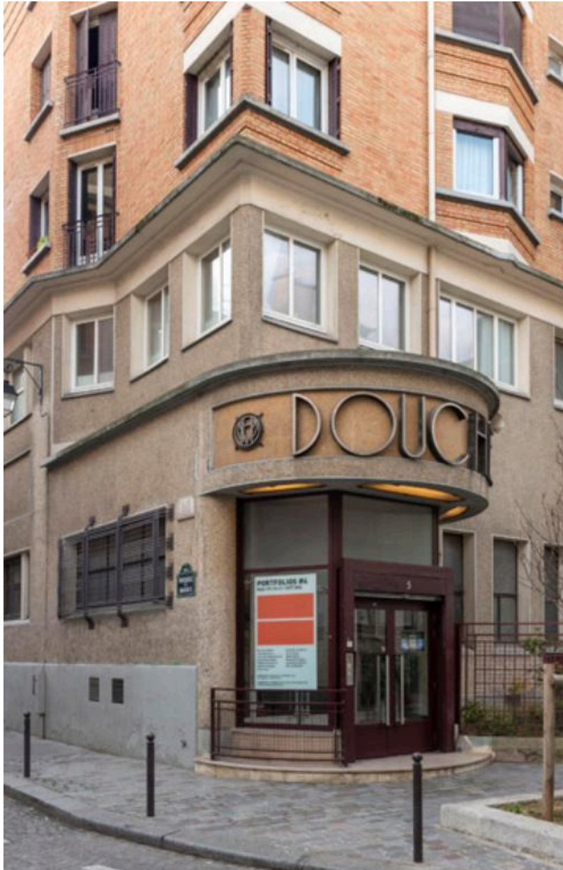
Détail de l'entrée des bains-douches de la rue Legouvé, avec leur avant-corps semi-circulaire.
