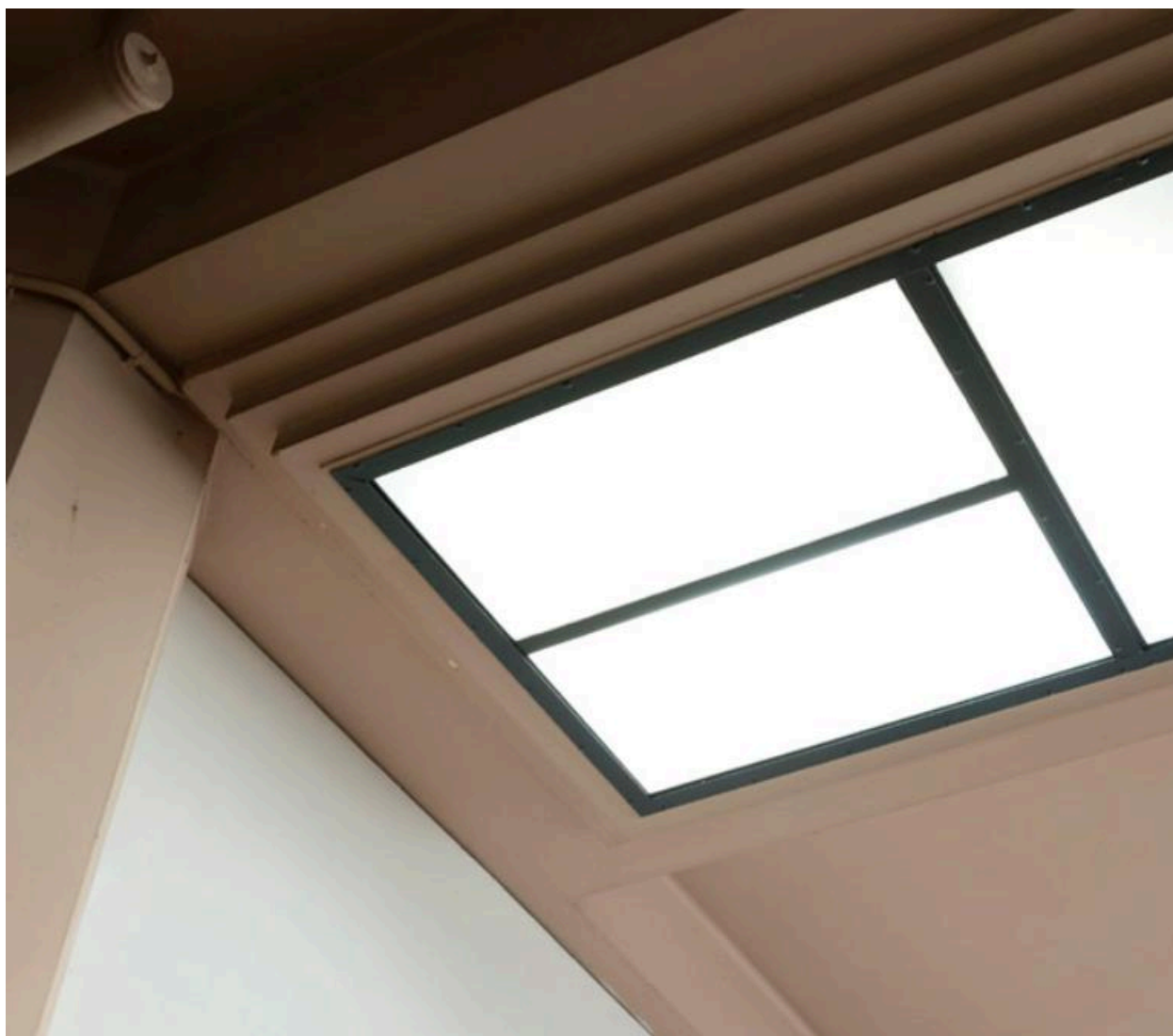
L'éclairage zénithal de la cage d'escalier.
