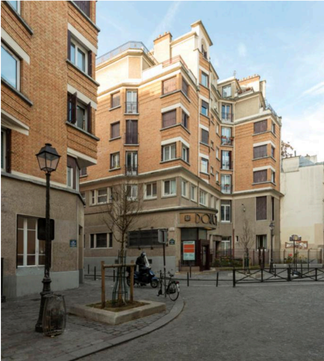
Vue générale du programme d'HBM de la rue Legouvé, avec l'entrée des bains-douches au rez-de-chaussée.
