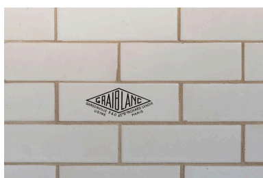
Détail d'une brique en grès émaillé produite dans l'usine GRAIBLANC de Gargenville (Yvelines) utilisée pour le revêtement des murs des cabines. Phot. Laurent Kruszyk IVR11_20177500072NUC4A
