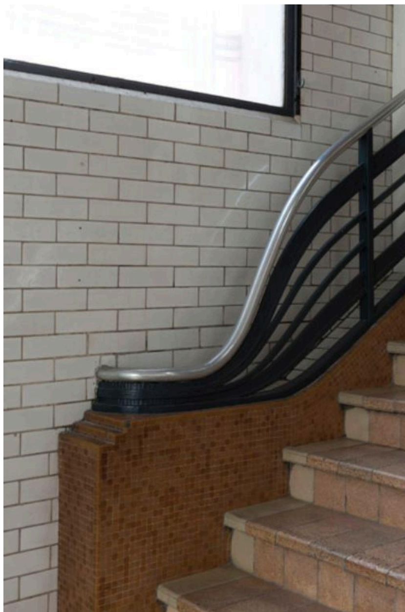
Détail du départ de rampe de l'escalier conduisant au premier étage et au service de douches des hommes.
