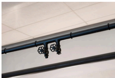
Détail des canalisations apportant l'eau chaude et l'eau froide dans les douches. Phot. Laurent Kruszyk IVR11_20177500109NUC4A
