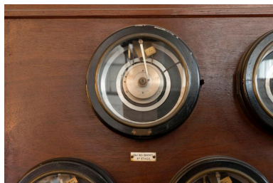
Détail d'un thermostat. La température des douches devait être constante et maintenue à environ 39 degrés. Phot. Laurent Kruszyk IVR11_20177500108NUC4A
