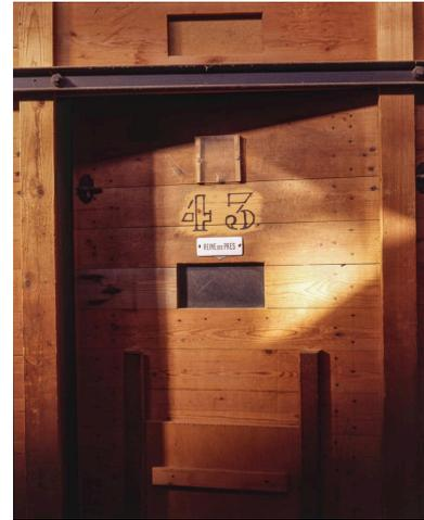
Détail de la porte d'un silo. Une trappe permet de soutirer les plantes, le hublot assure le contrôle du remplissage du silo. La porte elle-même permet un accès aisé au silo pour son nettoyage.
