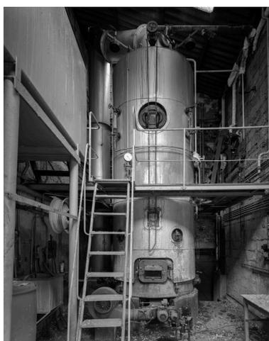
Chaudière à vapeur (alimentée au fuel lourd) chauffant les bâtiments et les cuves d'extraction, installée dans le "hangar", côté rue des Fossés.
