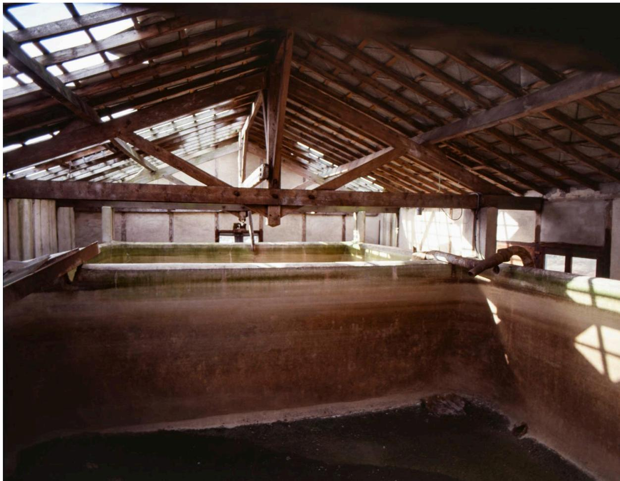
Intérieur du bâtiment de la citerne. L'eau pompée dans le ru de l'Opton (installations à côté de la maison du gardien du Moulin brûlé), servait à refroidir l'activité d'extraction végétale. L'eau chaude ne pouvant pas être directement rejetée dans la rivière, elle était stockée dans ce réservoir. L'hiver, après refroidissement durant la nuit, l'eau pouvait de nouveau être réutilisée au refroidissement, sans pompage inutile.
