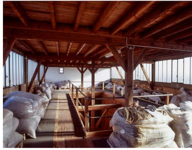
5ème étage ou mezzanine du bâtiment principal. Lieu de stockage (avant les sacs de plantes) de wagonnets contenant les plantes coupées et accès aux trappes permettant de remplir les silos.
