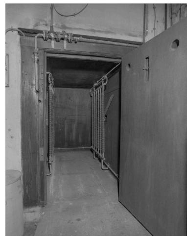
Bâtiment A (à l'angle des bâtiments C et F), étuve à vapeur pour sécher les extraits végétaux. Ils sont placés au sec dans une grande armoire, chauffée par un système de canalisation où circule la vapeur.
