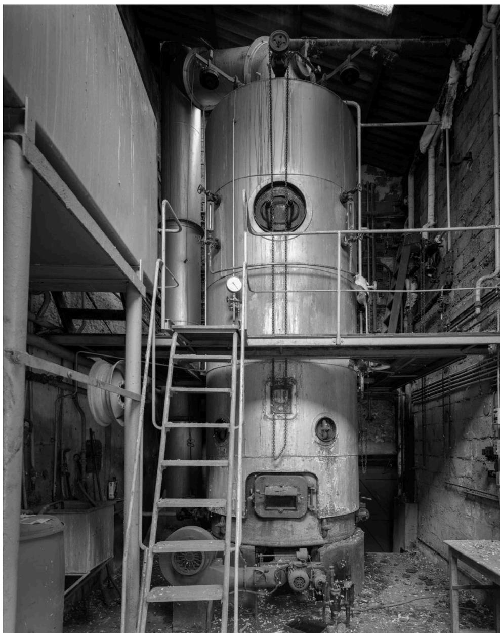
Chaudière à vapeur (alimentée au fuel lourd) chauffant les bâtiments et les cuves d'extraction, installée dans le "hanger", côté rue des Fossés.
