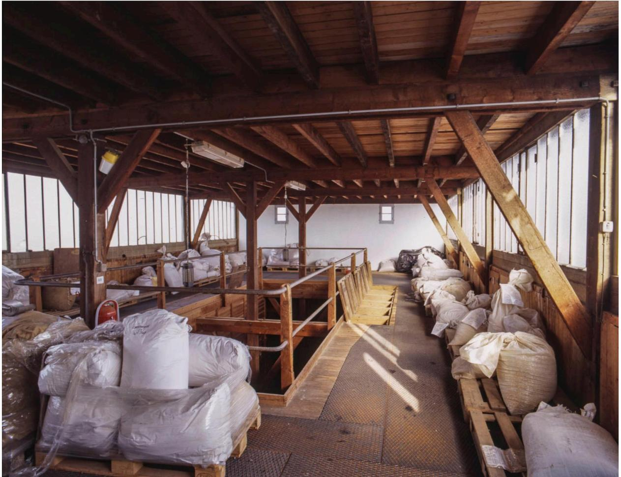
5ème étage ou mezzanine du bâtiment principal. Lieu de stockage (avant les sacs de plantes) de wagonnets contenant les plantes coupées et accès aux trappes permettant de remplir les silos. Détail de trappes ouvertes.
