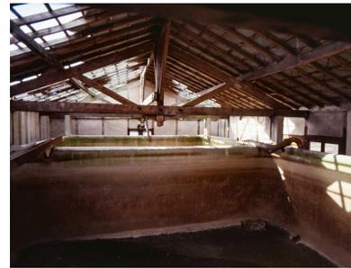
Intérieur du bâtiment de la citerne. L'eau pompée dans le ru de l'Opton (installations à côté de la maison du gardien du Moulin brûlé), servait à refroidir l'activité d'extraction végétale. L'eau chaude ne pouvant pas être directement rejetée dans la rivière, elle était stockée dans ce réservoir. L'hiver, après refroidissement durant la nuit, l'eau pouvait de nouveau être réutilisée au refroidissement, sans pompage inutile. Phot. Stéphane Asseline
