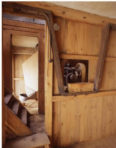
Petite pièce implantée entre le 4e et le 3e étage du bâtiment principal. Elle contenait deux mélangeurs cubiques en bois (mélanges des plantes pour la confection des tisanes). L'un des deux mélangeurs a été démonté et placé au 2e étage.
