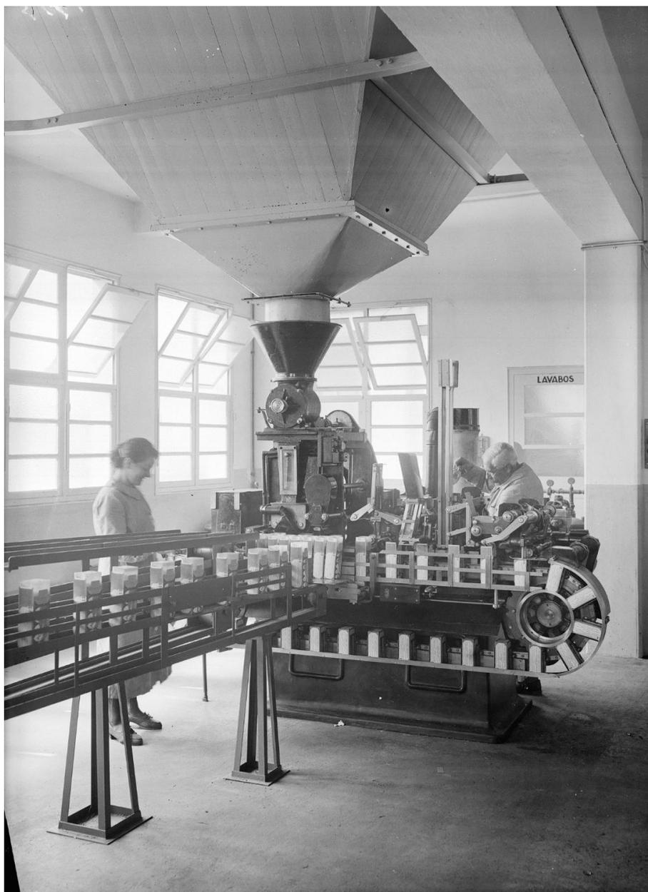
Machine remplissant les boites de tisane en vrac en fonctionnement.
