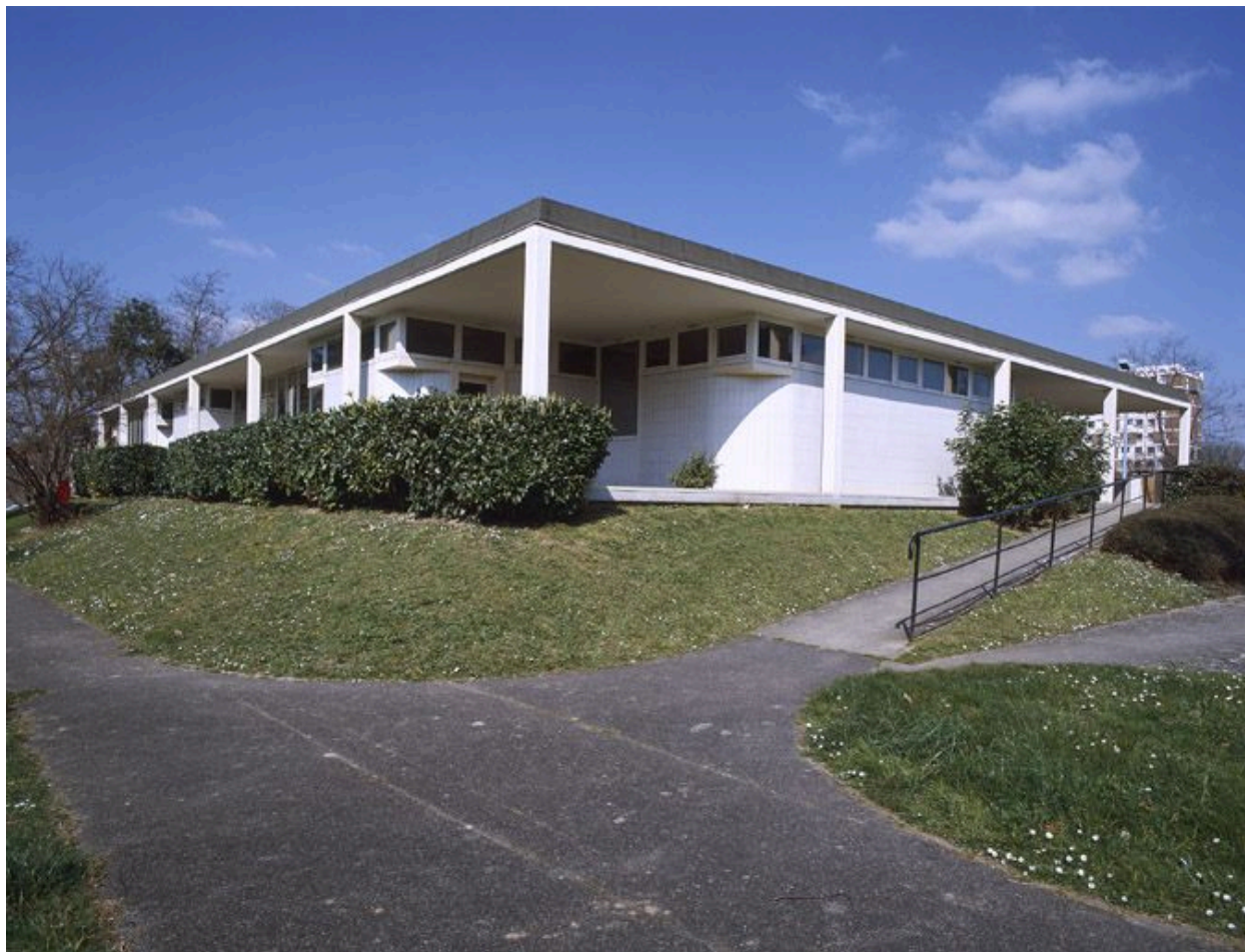
Façades latérale sud et postérieure.
