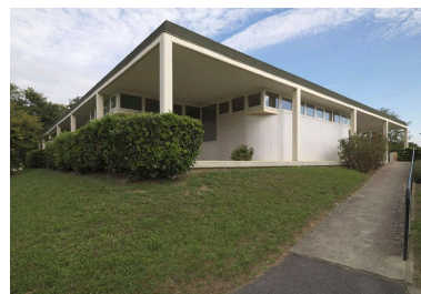
Façades arrière et latérale du bâtiment. Phot. Philippe Ayrault IVR11_20089100050NUC4A
