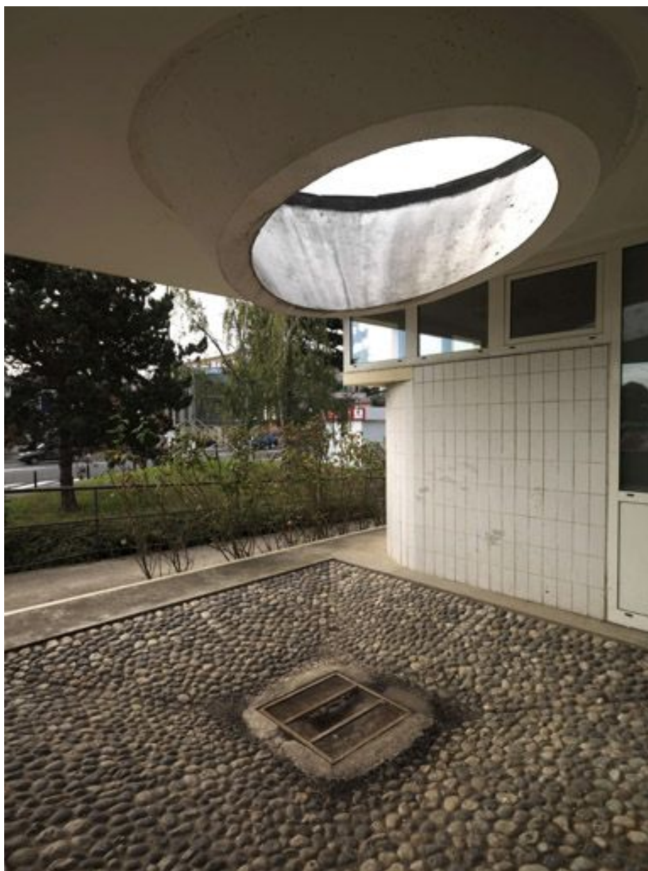
Puits de lumière percé dans la toiture.
