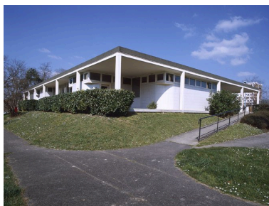
Façades latérale sud et postérieure. Phot. Philippe Ayrault IVR11_20079101303XA
