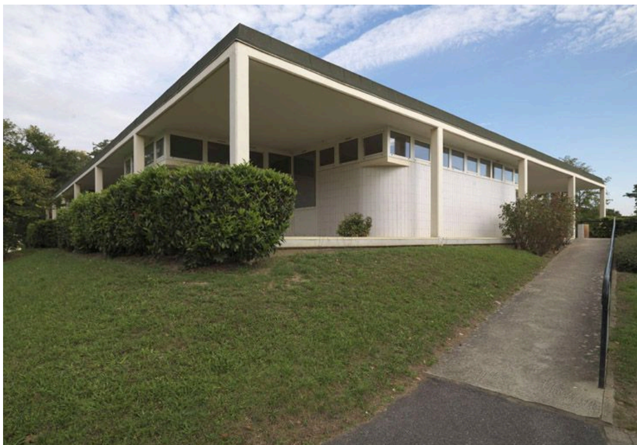
Façades arrière et latérale du bâtiment.
