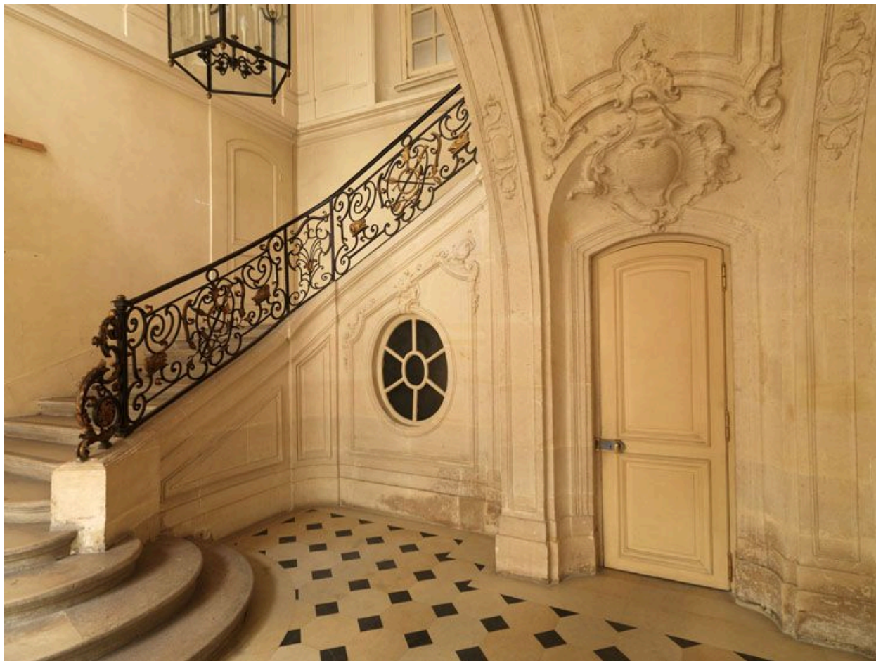
Vue d'ensemble de l'escalier depuis le vestibule : la voûte de l'escalier et l'agrafe rocaille de la porte.
