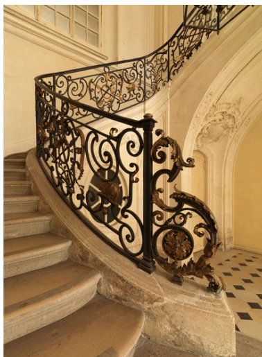
La console de départ. Phot. Laurent Kruszyk IVR11_20107500298NUC4A
