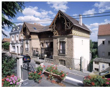
Vue d'ensemble. Phot. Philippe Ayrault IVR11_20049100489XA
