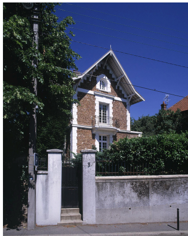
Vue d'ensemble. Phot. Philippe Ayrault IVR11_20049100420XA
