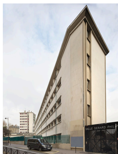
La barre incurvée du lycée forme à sa pointe, sur la rue Corvisart, un angle abrupt, traité en biseau. Phot. Stéphane Asseline IVR11_20197500145NUC4A
