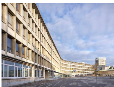
Le lycée a subi très peu de modifications depuis sa construction. Une partie des préaux, au rez-de-chaussée, ont toutefois été occultés et fermés pour créer de nouvelles salles. Phot. Stéphane Asseline IVR11_20197500139NUC4A
