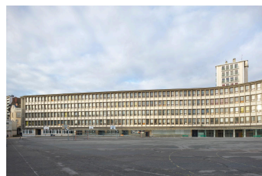
Les façades sur cour sont rigoureusement tramées, selon le module de base d'1,75 m de côté adopté par le ministère de l'Éducation nationale en 1952. Phot. Stéphane Asseline IVR11_20197500128NUC4A
