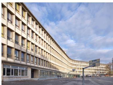
La longue barre incurvée de l'établissement, réalisée à partir de panneaux préfabriqués sur place. Phot. Stéphane Asseline IVR11_20197500130NUC4A
