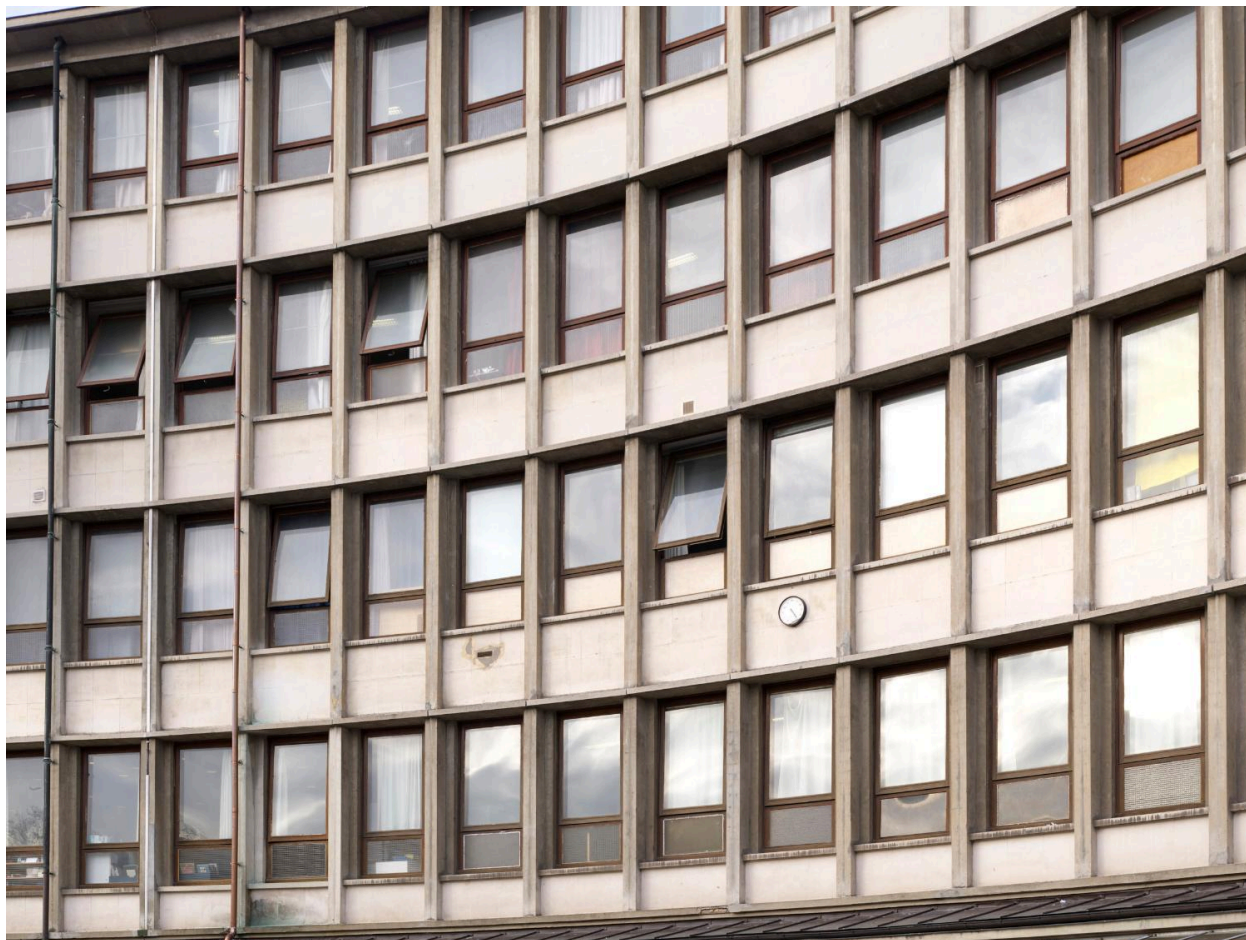
Détail de la trame et des panneaux préfabriqués (façade sur cour).
