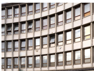
Détail de la trame et des panneaux préfabriqués (façade sur cour). Phot. Stéphane Asseline IVR11_20197500138NUC4A
