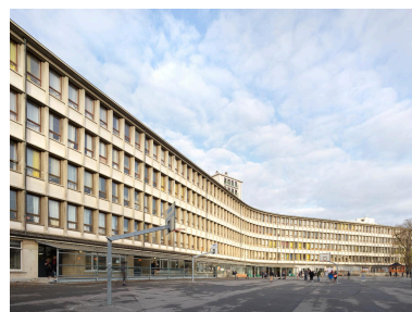
Sur cour, la façade se compose d'étroites travées pourvues de baies légèrement renfoncées. Celles-ci viennent scander la trame que l'architecte rend ainsi visible. Phot. Stéphane Asseline IVR11_20197500131NUC4A
