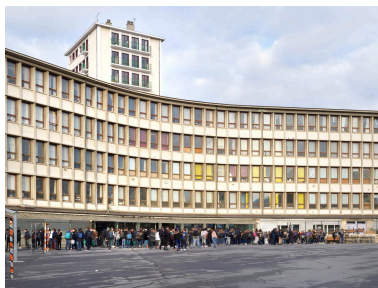
La tour d'habitation, qui se fond dans un quartier marqué par la présence de nombreux Immeubles de Grande Hauteur (IGH), abrite les bureaux de l'administration et des appartements dans ses niveaux supérieurs. Phot. Stéphane Asseline IVR11_20197500133NUC4A
