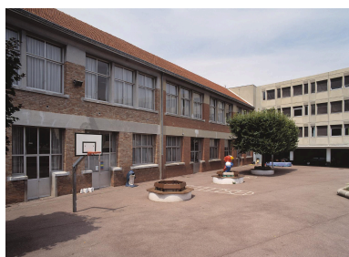
Façade sur la cour de l'aile gauche de l'école primaire ; au fond, le bâtiment du collège. Phot. Philippe Ayrault
