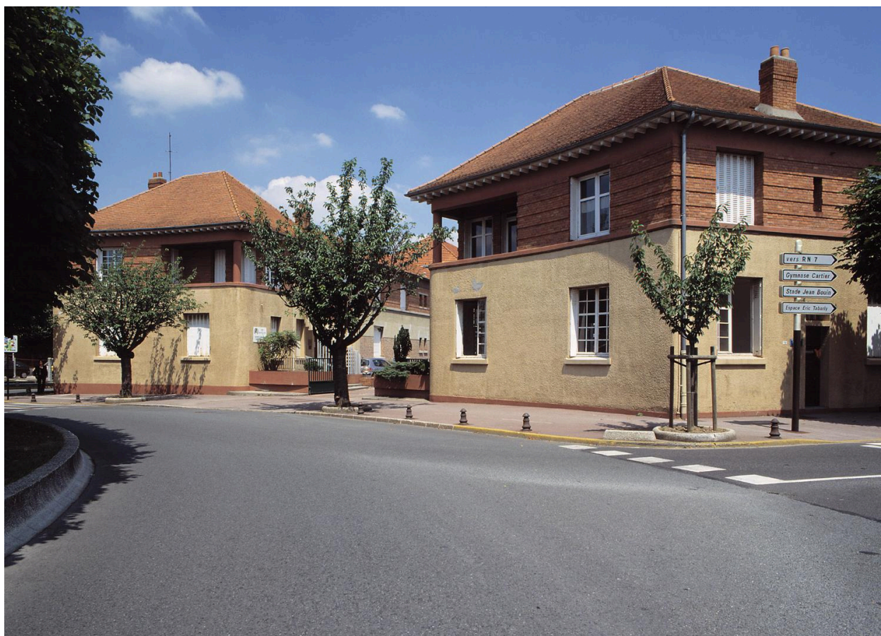
Vue des deux pavillons d'entrée sur la place Henri-Barbusse.
