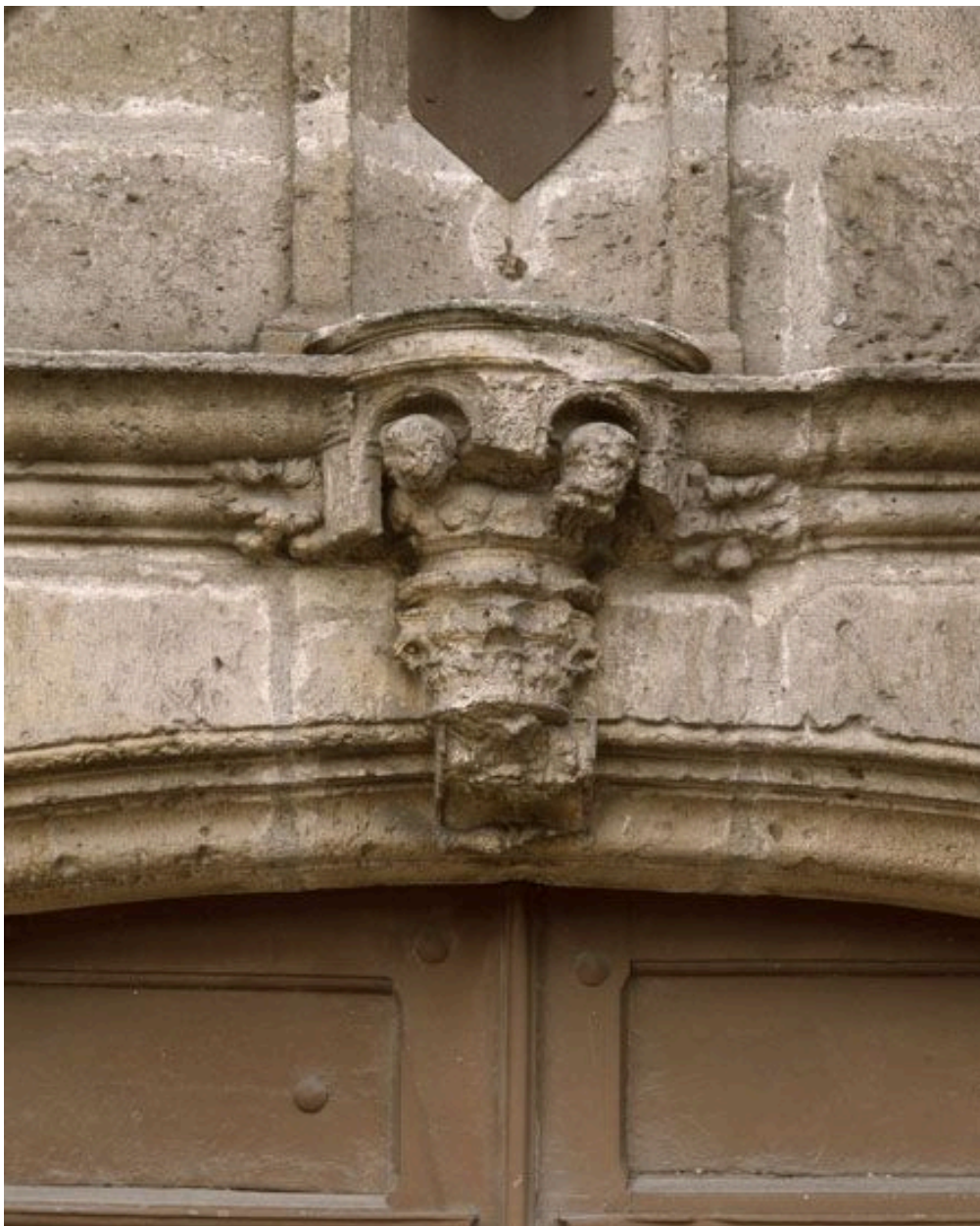
Détail du culot destiné à recevoir une statue dans la niche du portail.
