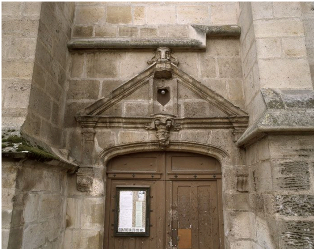
Vue d'ensemble du portail s'ouvrant sur le chevet.
