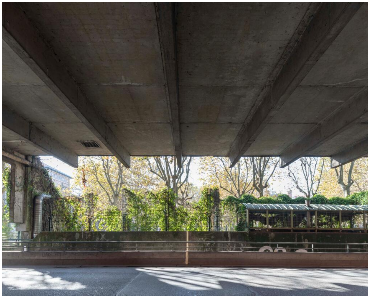
Patinoire de Saint-Ouen. Voie publique sous bâtiment en porte-à-faux.
