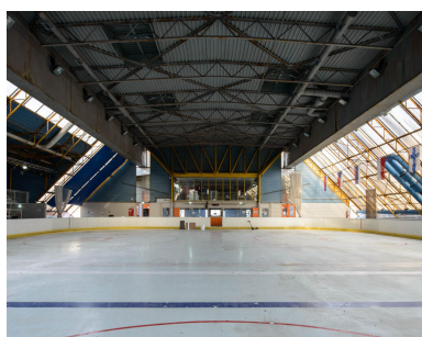
Patinoire de Saint-Ouen. Vue de l'espace intérieur. Phot. Dupuid Augustin IVR11_20219300591NUC4A
