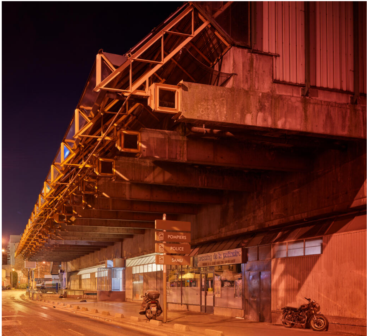
La patinoire de Saint-Ouen, architecte Paul Chemetov, 1979.
