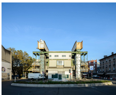
Patinoire de Saint- Ouen. Façade postérieure. Phot. Dupuid Augustin IVR11_20219300581NUC4A
