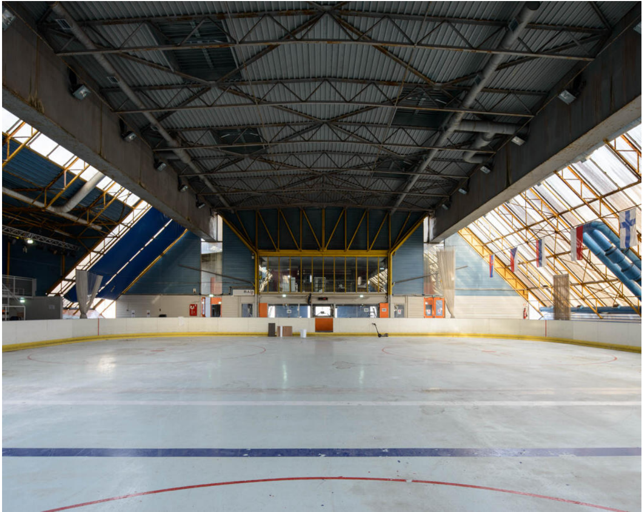
Patinoire de Saint-Ouen. Vue de l'espace intérieur.
