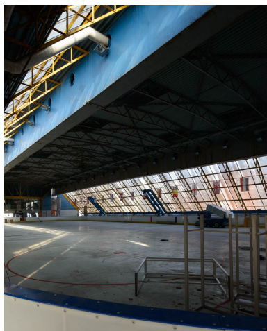
Patinoire de Saint-Ouen. Phot. Dupuid Augustin IVR11_20219300614NUC4A
