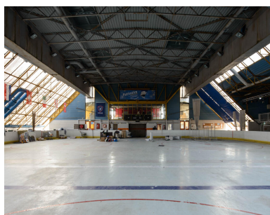
Patinoire de Saint-Ouen. Phot. Dupuid Augustin IVR11_20219300592NUC4A
