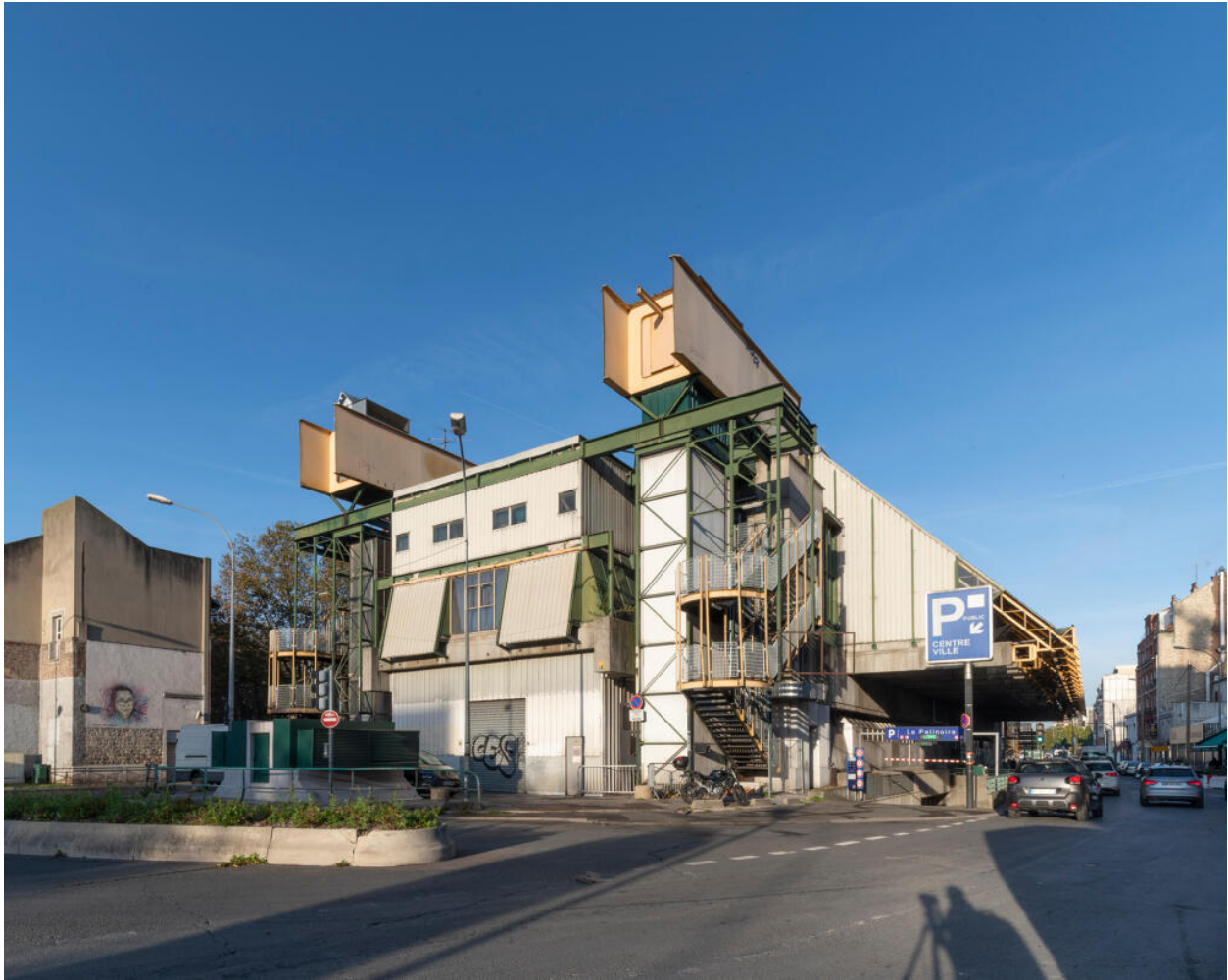
Patinoire de Saint-Ouen. Vue de la façade postérieure.
