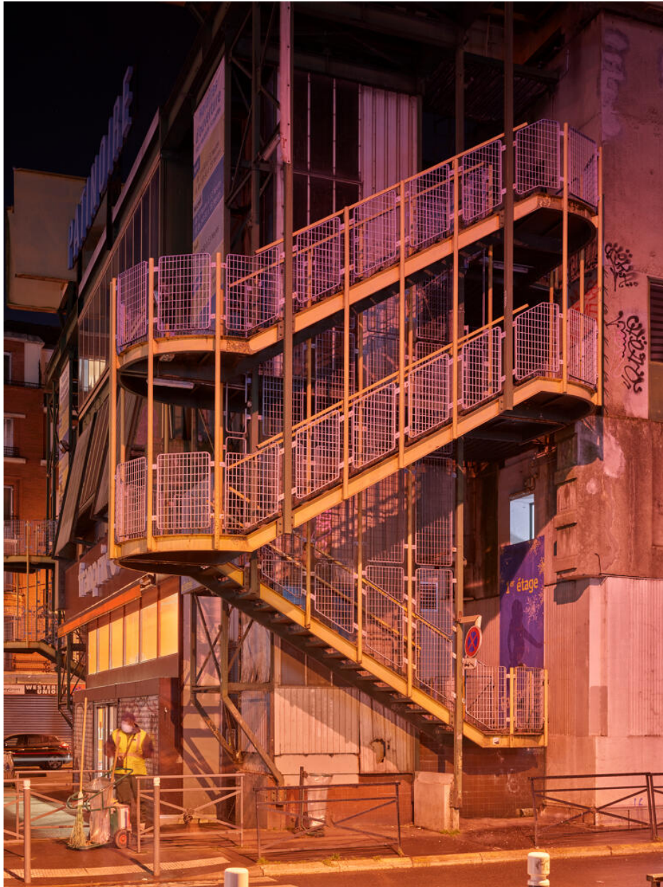
La patinoire de Saint-Ouen, architecte Paul Chemetov, 1979.
