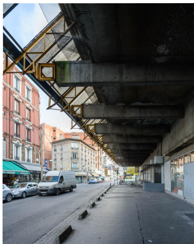
Patinoire de Saint-Ouen. Phot. Dupuid Augustin IVR11_20219300951NUC4A
