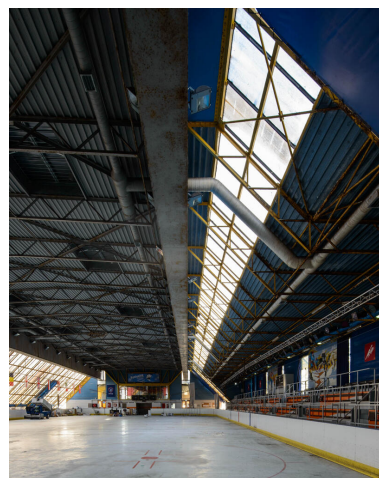
Patinoire de Saint-Ouen. Phot. Dupuid Augustin IVR11_20219300584NUC4A
