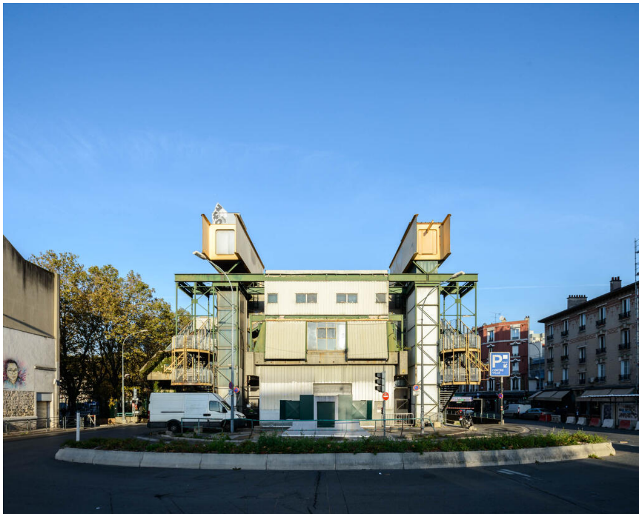
Patinoire de Saint-Ouen. Façade postérieure.
