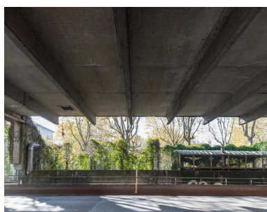
Patinoire de Saint-Ouen. Voie publique sous bâtiment en porte-à-faux. Phot. Ayrault Philippe IVR11_20219300782NUC4A
