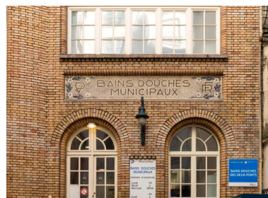
Détail des baies du rez-de- chaussée surélevé et de l'inscription "Bains-douches municipaux".
