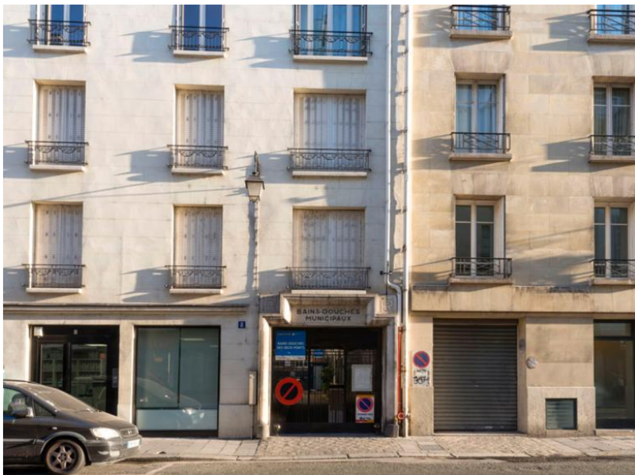
L'entrée des bains-douches depuis la rue des Deux-Ponts.
