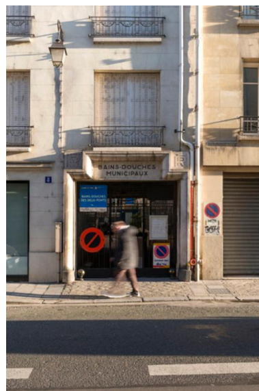
L'entrée des bains-douches de la rue des Deux-Ponts, au rez-de- chaussée de l'immeuble du numéro 8. Phot. Laurent Kruszyk IVR11_20177500047NUC4A
