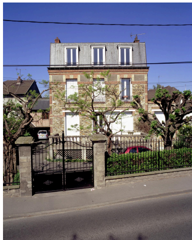
Vue d'ensemble. Phot. Philippe Ayrault IVR11_20039100586XA
