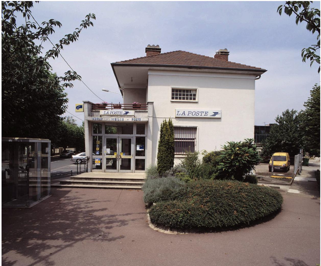
Vue de la façade sur la place Henri-Barbusse.
