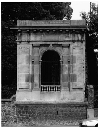
Vue partielle de la colonnade prise depuis la rue. Phot. Christian Décamps IVR11_19859400916V
