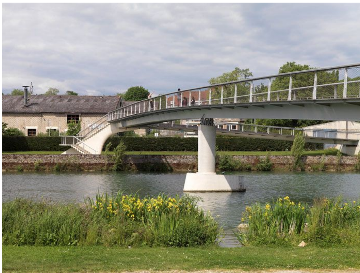
La passerelle, vue de la rive orientale.
