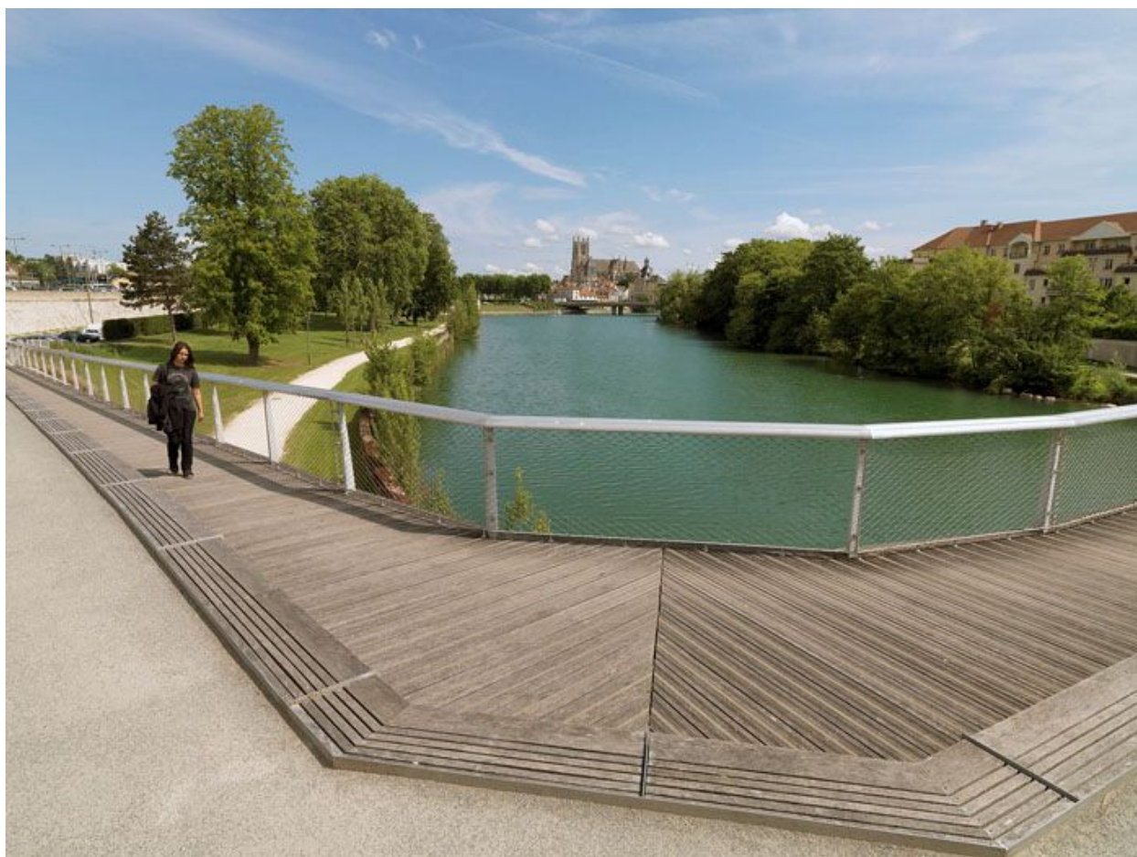
La partie tournante de la passerelle, vers le jardin des Trinitaires et la gare.
