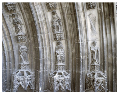
Les sculptures du portail Saint-Jean-Baptiste, vues depuis l'échafaudage dressé pour la restauration de la base de la tour nord (2008) : le départ des voussures, à droite du tympan. Phot. Stéphane Asseline IVR11_20087700359XA
