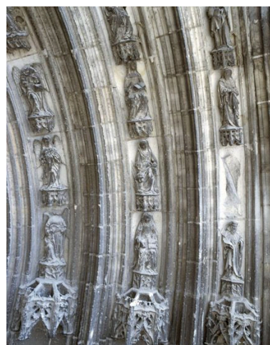
Les sculptures du portail Saint-Jean-Baptiste, vues depuis l'échafaudage dressé pour la restauration de la base de la tour nord (2008) : les voussures, à droite du tympan. Phot. Stéphane Asseline IVR11_20087700357XA
