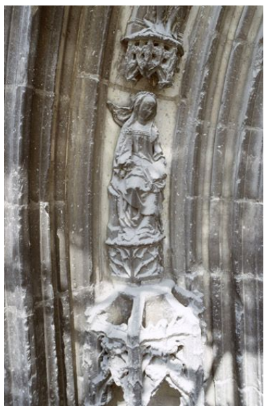
Les sculptures du portail Saint-Jean-Baptiste, vues depuis l'échafaudage dressé pour la restauration de la base de la tour nord (2008) : détail d'une sainte lisant, au départ de la voussure centrale (à gauche du tympan). Phot. Stéphane Asseline IVR11_20087700356XA
