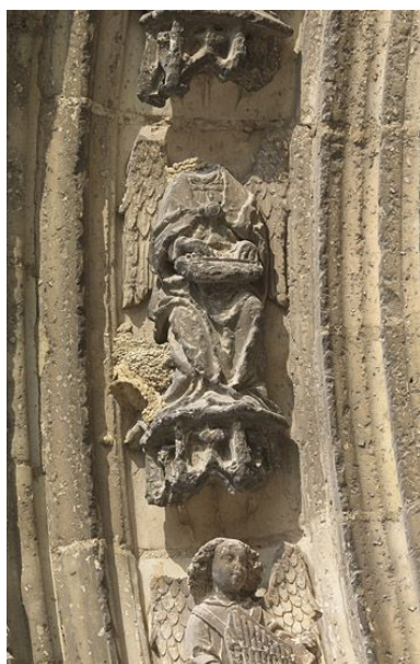
Détail de la voussure intérieure : 3e claveau gauche, ange musicien (étêté). Phot. Stéphane Asseline IVR11_20097700223NUC4A
