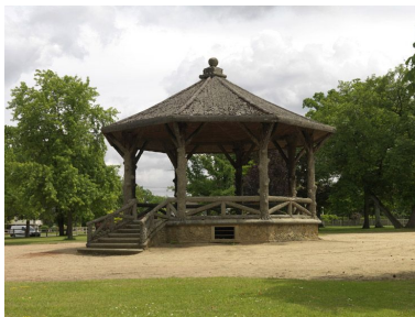
Vue d'ensemble. Phot. Philippe Ayrault IVR11_20137800314NUC4A
