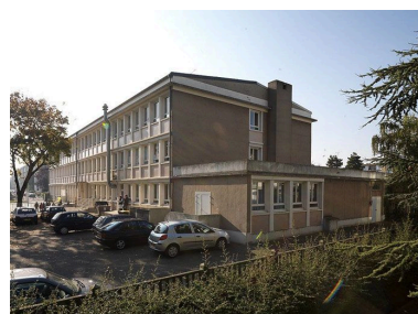
Vue d'ensemble. Phot. Philippe Ayrault IVR11_20089100227NUC4A
