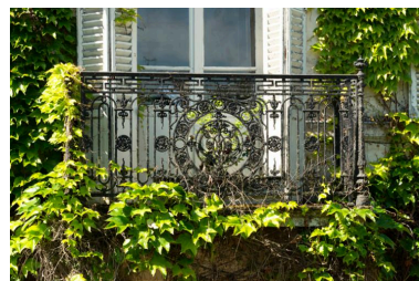
Le garde-corps en fonte du balcon central du premier étage. Phot. Philippe Ayrault IVR11_20177800363NUC4A
