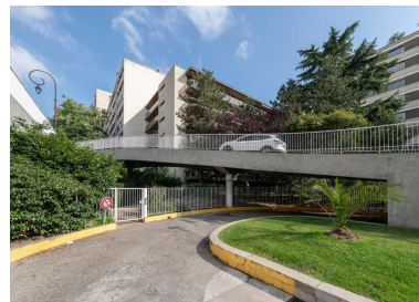
Résidence Parc de Béarn, rampes d'accès au garage souterrain Phot. Kruszyk Laurent IVR11_20249200373NUC4A
