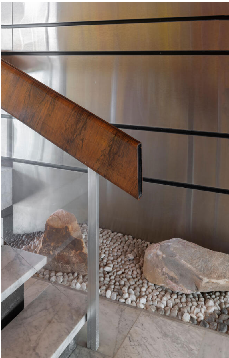
Résidence Parc de Béarn, détail d'un hall d'entrée
