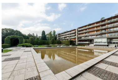
Résidence Parc de Béarn, miroir d'eau de la terrasse Phot. Kruszyk Laurent IVR11_20249200378NUC4A
