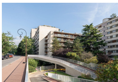
Résidence Parc de Béarn, rampes d'accès au garage souterrain Phot. Kruszyk Laurent IVR11_20249200372NUC4A
