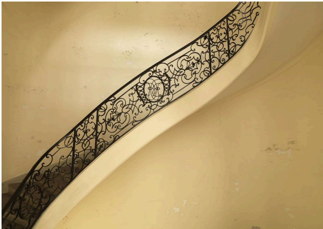
Détail d'une partie rampante.
