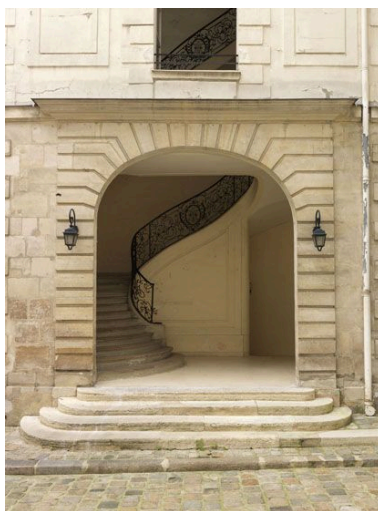
Départ de l'escalier précédé d'un vestibule ouvert. Phot. Laurent Kruszyk IVR11_20097501377NUC4A
