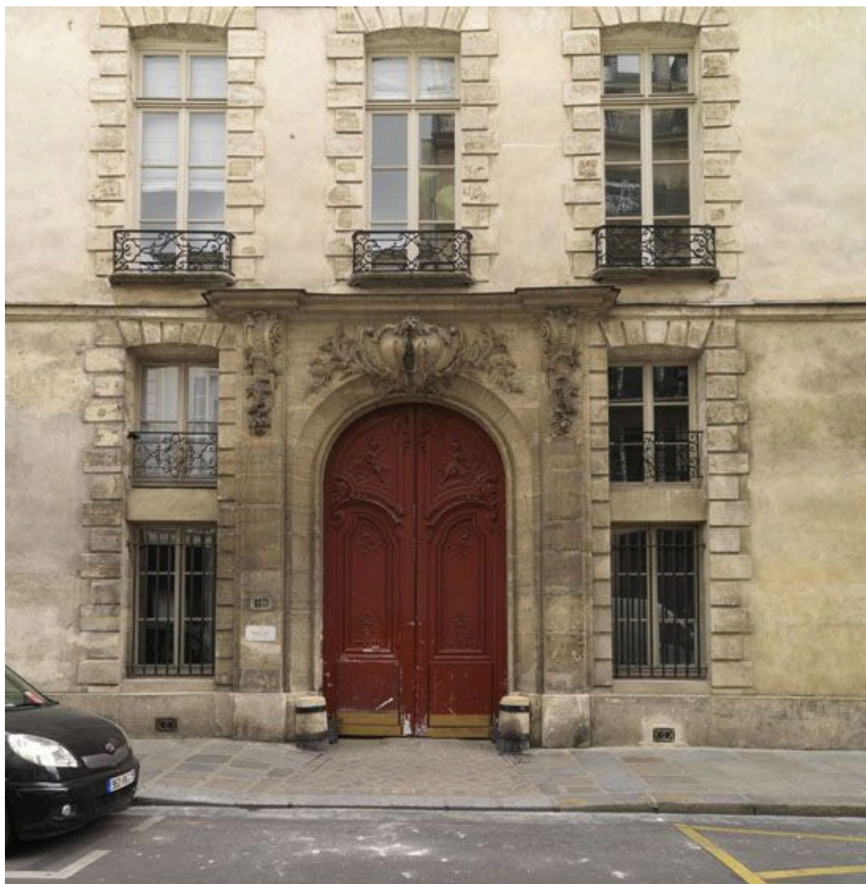
Vue de la porte cochère refaite en 1731-1733.
