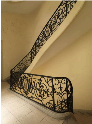
Vue d'une volée. Phot. Laurent Kruszyk IVR11_20097501380NUC4A
