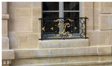
un garde corps au chiffre des rois de France. Phot. Philippe Ayrault IVR11_20107500271NUC4A
