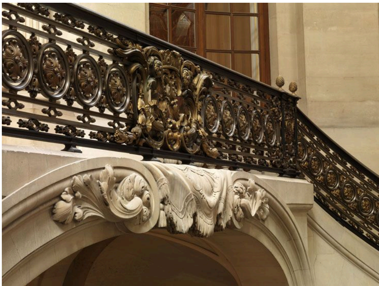
La rampe d'appui du palier.
