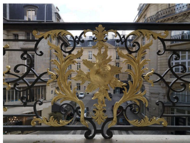
Détail du motif central du balcon : une nuée ardente (à finir). Phot. Philippe Ayrault IVR11_20107500268NUC4A
