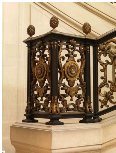
Gaine de départ vue de trois-quarts. Phot. Philippe Ayrault IVR11_20107500282NUC4A
