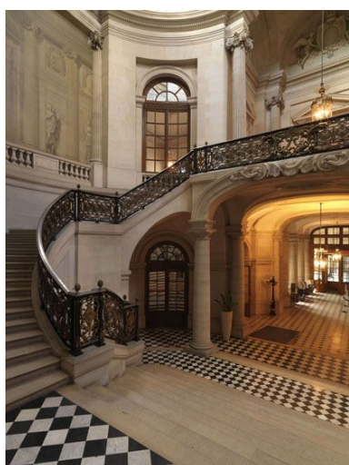
Après un départ central droit, l'escalier se divise en deux volées en fer à cheval. ici, la volée à droite.
