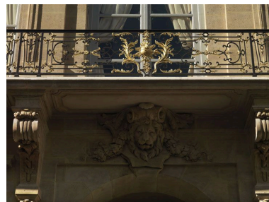
Balcon central de la façade sur la rue de Valois. On y voit une nuée ardente (à finir). Phot. Philippe Ayrault IVR11_20107500266NUC4A
