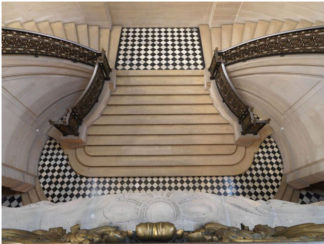
Vue de la première volée et du premier repos ou se trouvait primitivement la porte conduisant à l'opéra.
