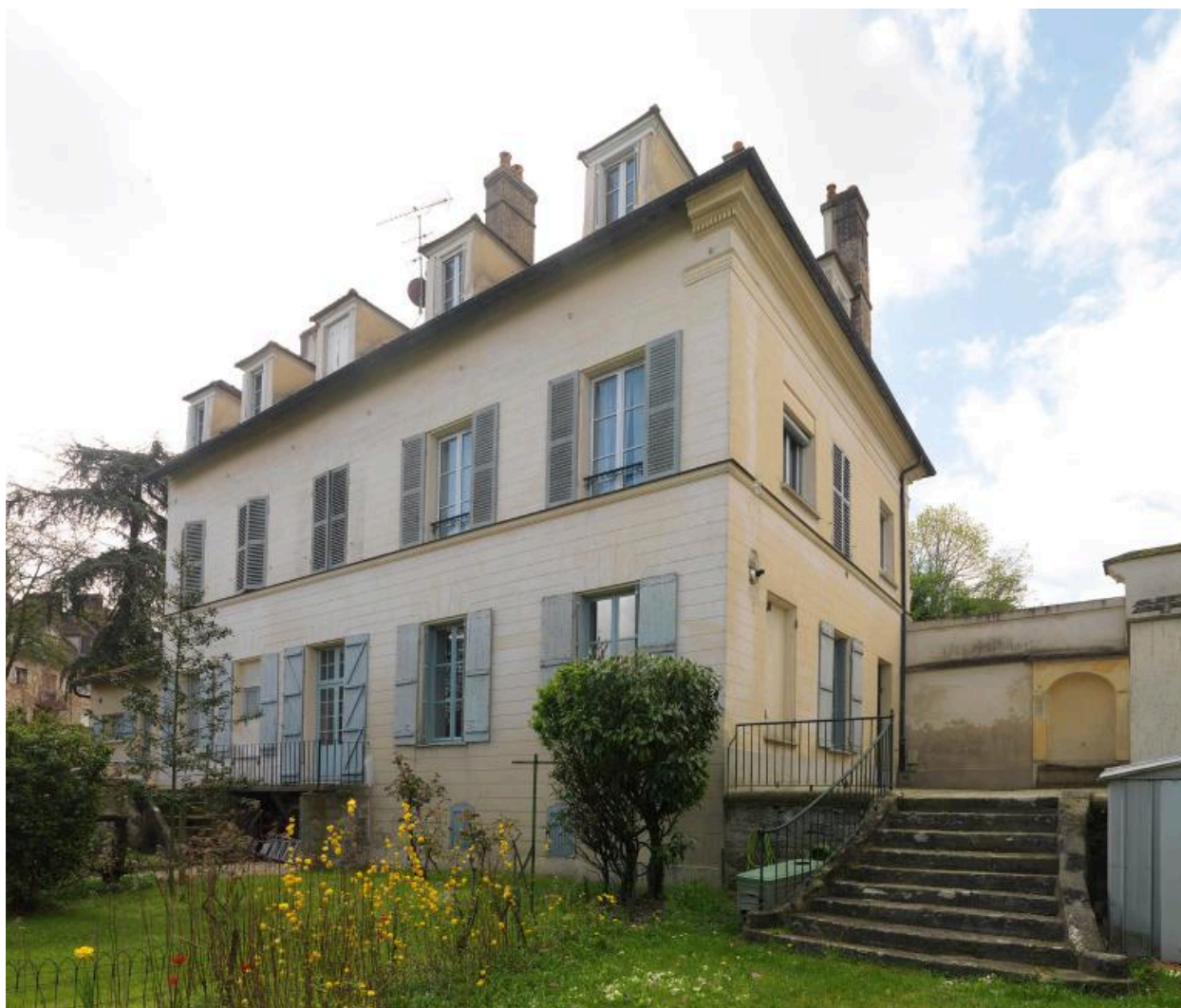
Vue de la façade sur jardin. Elle a perdu une partie de sa corniche.
