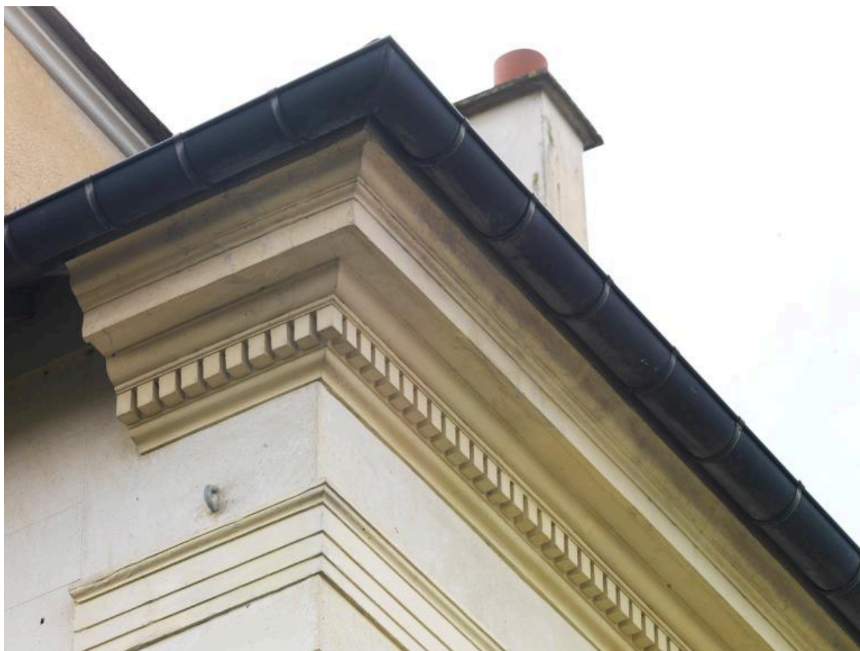
Détail de la très belle corniche à denticules.
