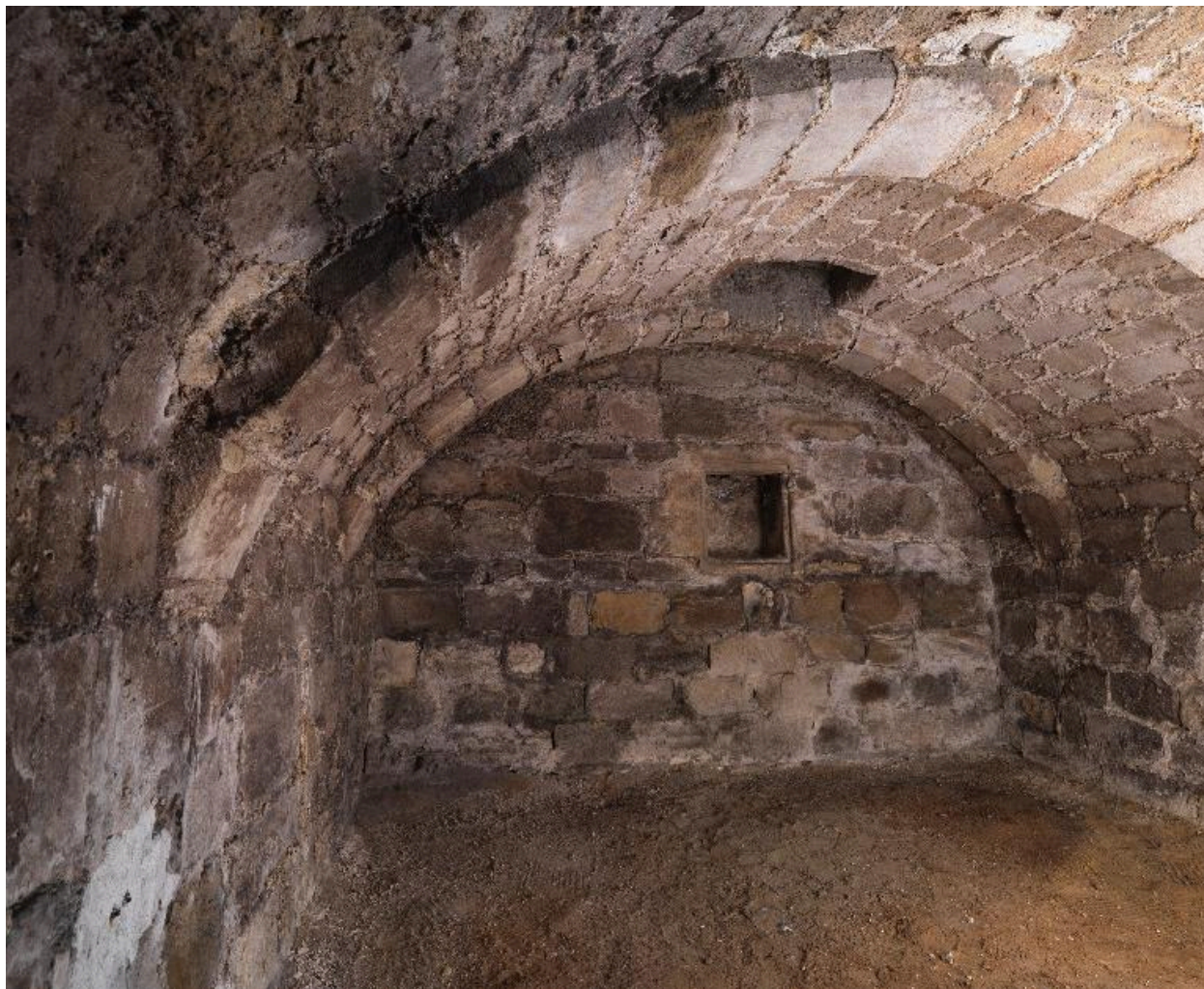
Vue de la deuxième cave construite en bel appareil.
