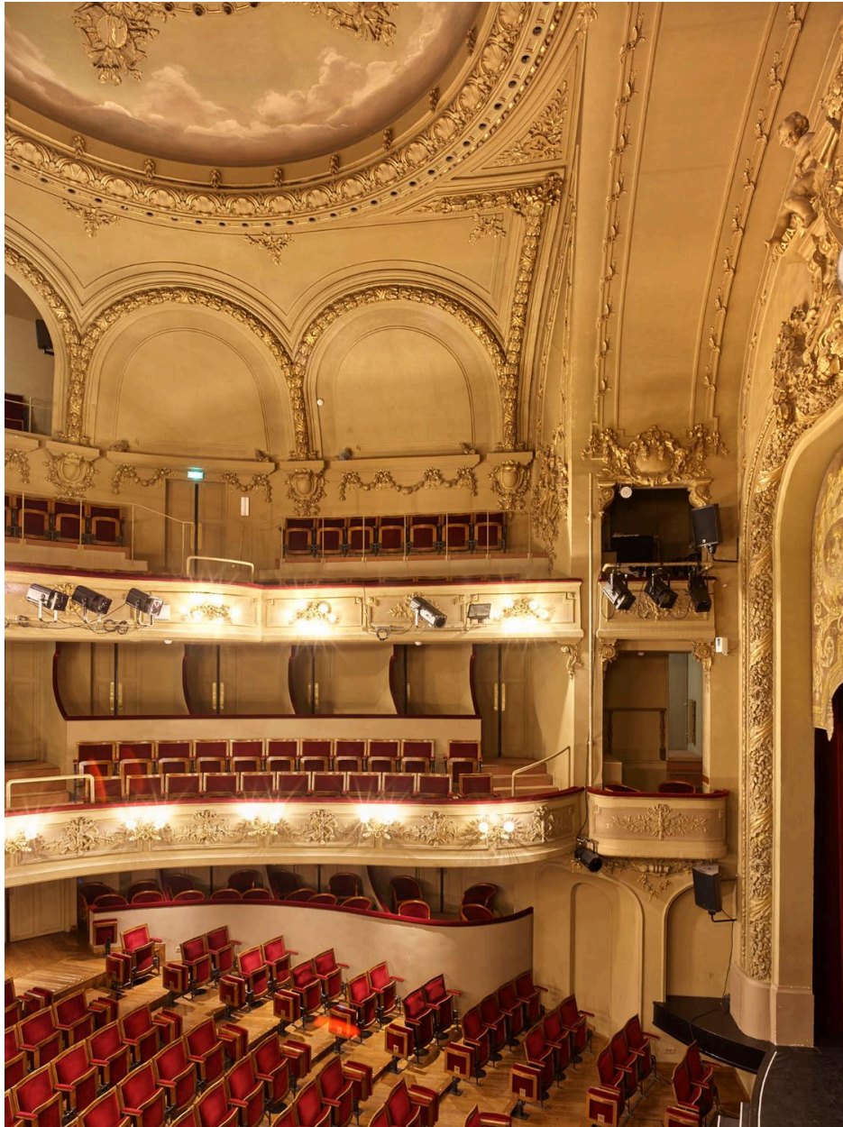
Vue des balcons suspendus sans point d'appui
