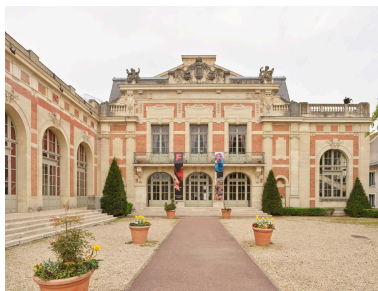
Façade principale sur cour du théâtre Phot. Stéphane Asseline IVR11_20217700014NUC6A
