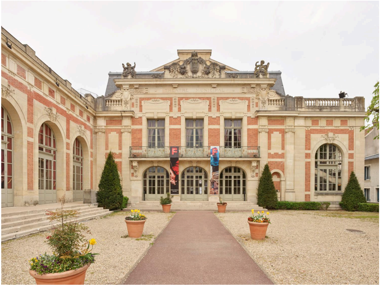
Façade principale sur cour du théâtre
