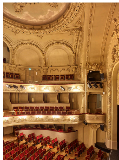
Vue des balcons suspendus sans point d'appui Phot. Stéphane Asseline IVR11_20217700020NUC6A
