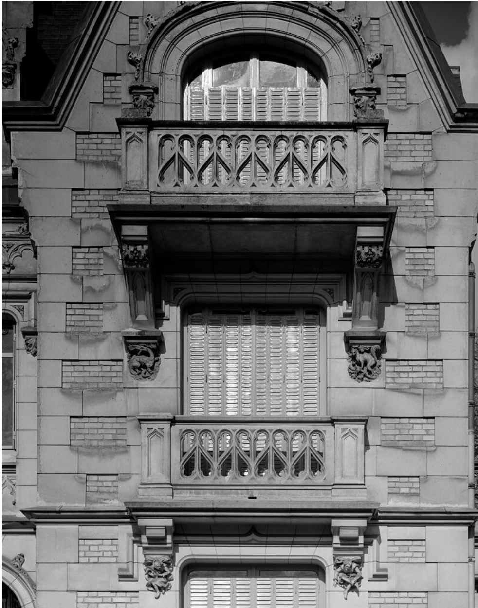
Détail des balcons de la façade antérieure.
