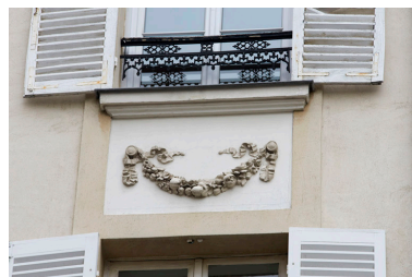
Vue du décor sculpté de la façade. Phot. Laurent Kruszyk IVR11_20157500644NUC4A
