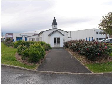
2014, bâtiment dit "chapelle de l'OTAN" vu depuis le sud ouest. Phot. Stéphane Asseline IVR11_20209400572NUC4A
