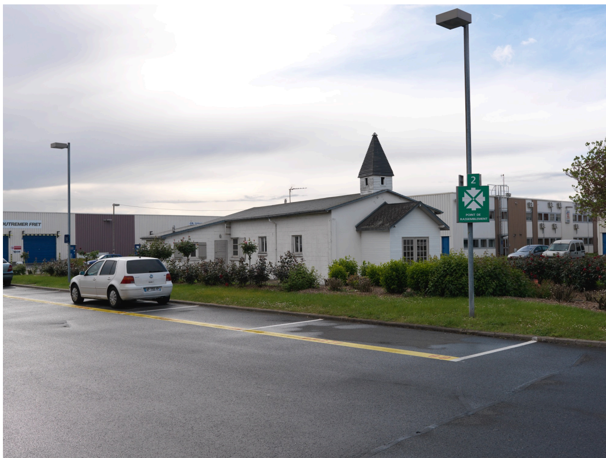
2014, bâtiment dit "chapelle de l'OTAN" vu depuis le sud.
