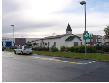
2014, bâtiment dit "chapelle de l'OTAN" vu depuis le sud. Phot. Stéphane Asseline IVR11_20209400573NUC4A
