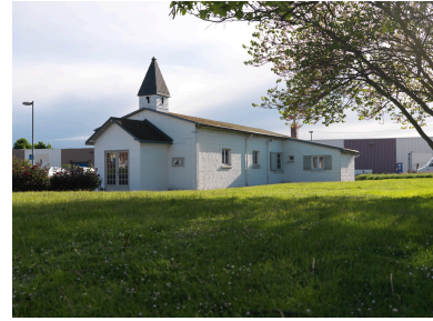
2014, bâtiment dit "chapelle de l'OTAN" vu depuis le nord. Phot. Stéphane Asseline IVR11_20209400574NUC4A
