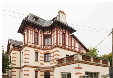
vue générale Phot. Laurent Kruszyk IVR11_20199100440NUC4A
