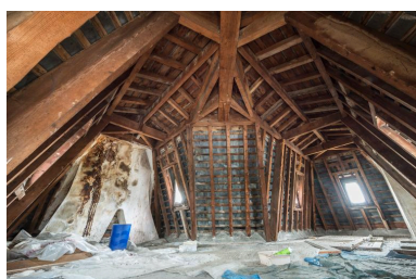
Détail charpente Phot. Laurent Kruszyk IVR11_20199100446NUC4A
