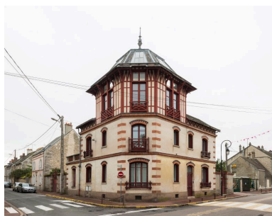
vue générale Phot. Laurent Kruszyk IVR11_20199100437NUC4A
