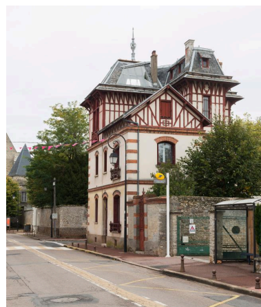
vue générale Phot. Laurent Kruszyk IVR11_20199100439NUC4A
