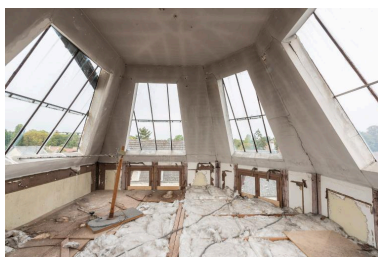
Intérieur de l'atelier Phot. Laurent Kruszyk IVR11_20199100444NUC4A
