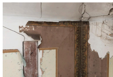
Détail de l'intérieur Phot. Laurent Kruszyk IVR11_20199100445NUC4A
