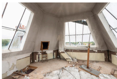
Intérieur de l'atelier Phot. Laurent Kruszyk IVR11_20199100443NUC4A
