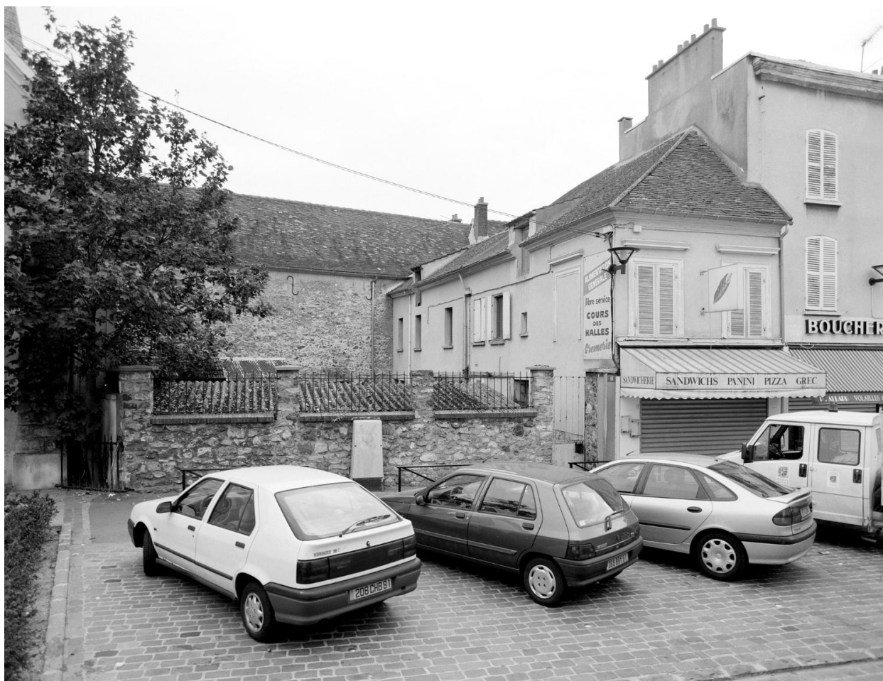
Bâtiment du 6, place de l'Eglise transformé en commerce et habitation.
