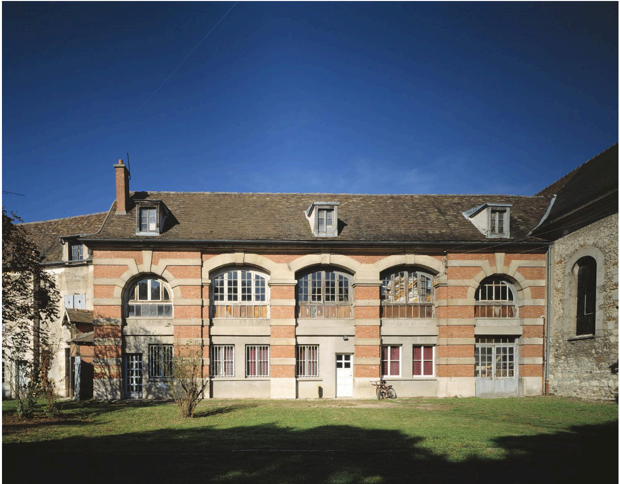
Ancien bâtiment du prieuré transformé en orangerie pour le château d'Athis. Sa façade brique et pierre date du début du 20e siècle.
