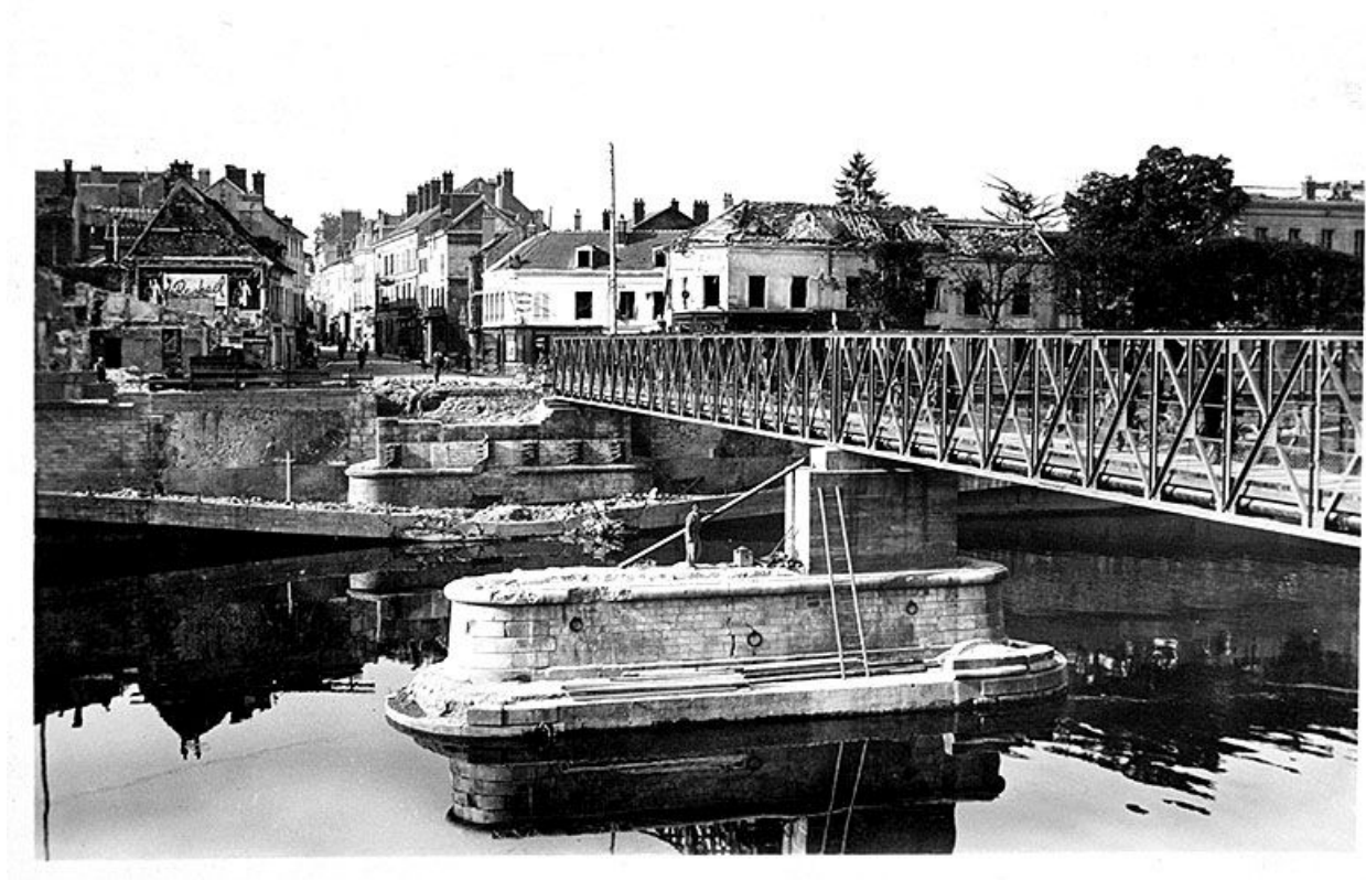
Passerelle remplaçant le ""pont de fer"" détruit pendant la Seconde guerre mondiale. Vue prise depuis l'île Saint-Etienne. Carte postale, milieu du 20e siècle. (BM Melun)
