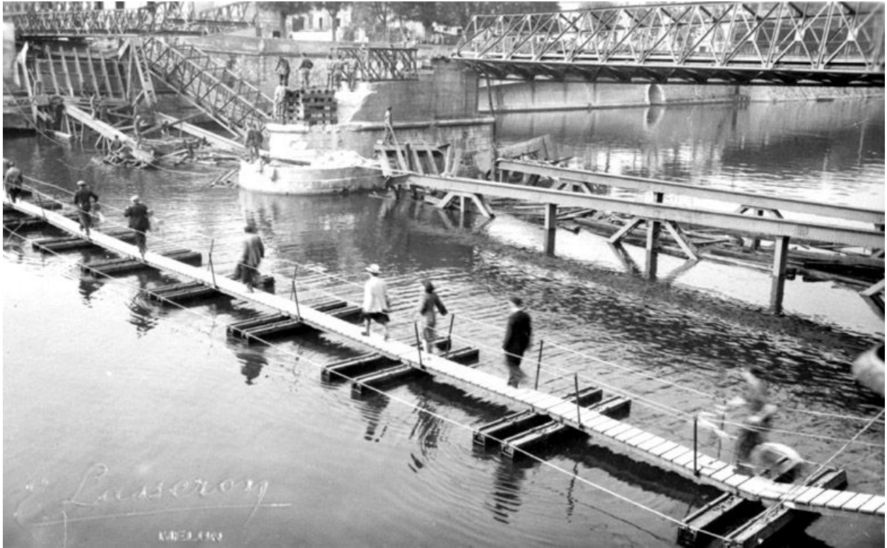
Passerelle provisoire établie sur le bras sud de la Seine pendant la Seconde guerre mondiale. Photographie. (AM Melun. 3 Fi 17)
