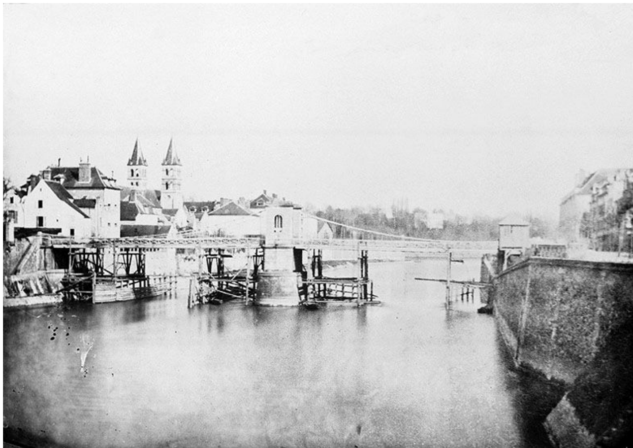
Pont suspendu construit en 1837, supprimé en 1869-1871, aujourd'hui pont de fer. Cliché de M. Laleu, épreuve de 1904, d'après une ancienne vue. (BM Melun. LL 4)
