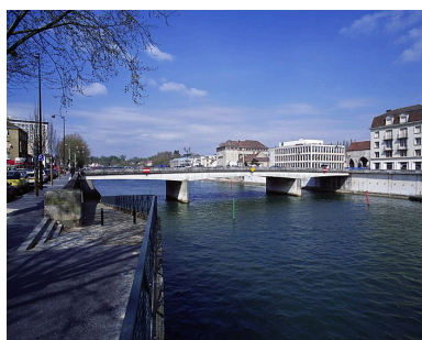
Vue générale, depuis l'amont.
