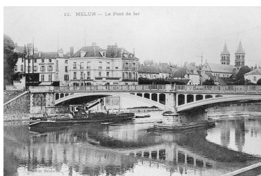
Partie nord du "pont de fer", vue de l'aval, vers le début du 20e siècle. Carte postale. (Musée municipal de Melun. inv. 983.2.64) Phot. Philippe Ayrault IVR11_20017700128X
