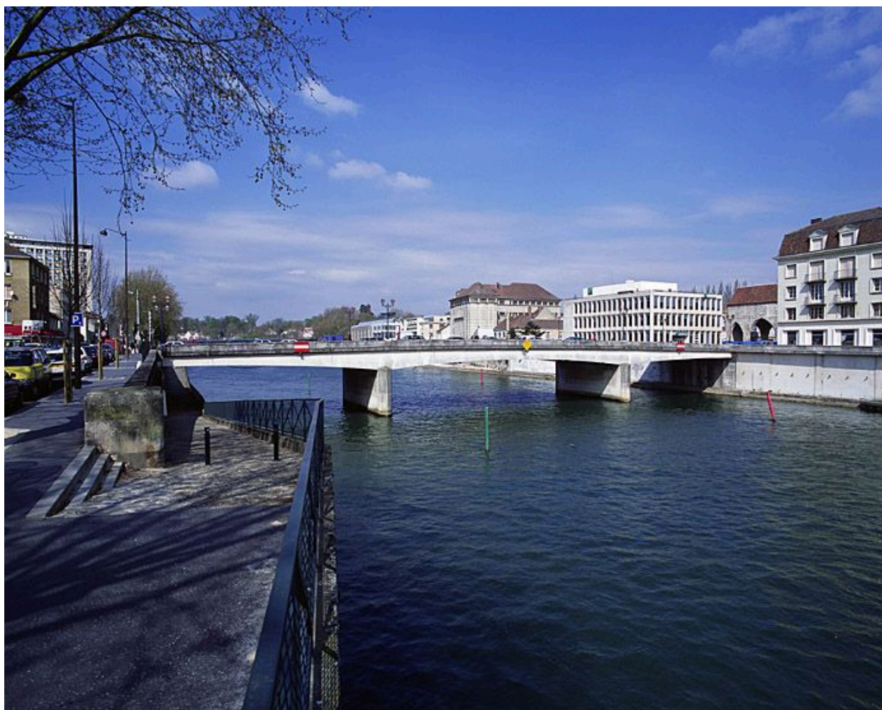
Vue générale, depuis l'amont.
