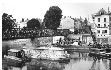
Passerelle temporaire élevée entre l'île Saint-Etienne et la rive gauche, sur les ruines du pont de fer détruit en 1940 lors de la Seconde guerre mondiale. Carte postale. (Musée municipal de Melun. inv. 992.16.18) Phot. Philippe Ayrault IVR11_20017700070X
