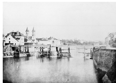
Pont suspendu construit en 1837, supprimé en 1869-1871, aujourd'hui pont de fer. Cliché de M. Laleu, épreuve de 1904, d'après une ancienne vue. (BM Melun. LL 4) Phot. Philippe Ayrault IVR11_20027701185X
