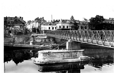
Passerelle remplaçant le "pont de fer" détruit pendant la Seconde guerre mondiale. Vue prise depuis l'île Saint-Etienne. Carte postale, milieu du 20e siècle. (BM Melun) Phot. Philippe Ayrault IVR11_20027701205X
