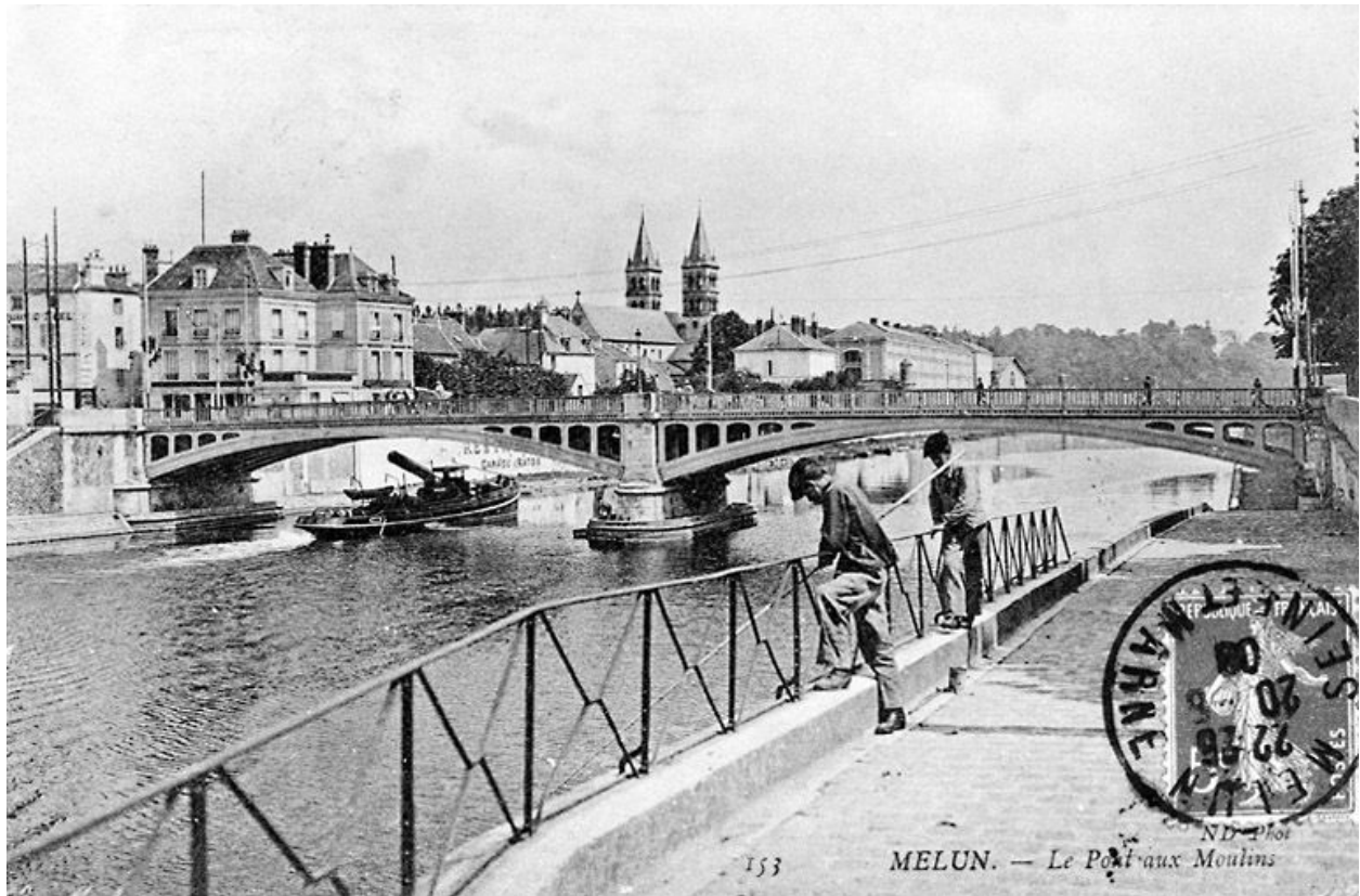
Vue du pont de fer ou pont aux moulins depuis l'ouest, vers 1908. Carte postale. (Musée municipal de Melun. inv. 983.2.66)
