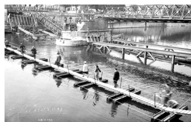
Passerelle provisoire établie sur le bras sud de la Seine pendant la Seconde guerre mondiale. Photographie. (AM Melun. 3 Fi 17) Phot. Philippe Ayrault, Autr. E. (photographe). Lasseron IVR11_20067700182X
