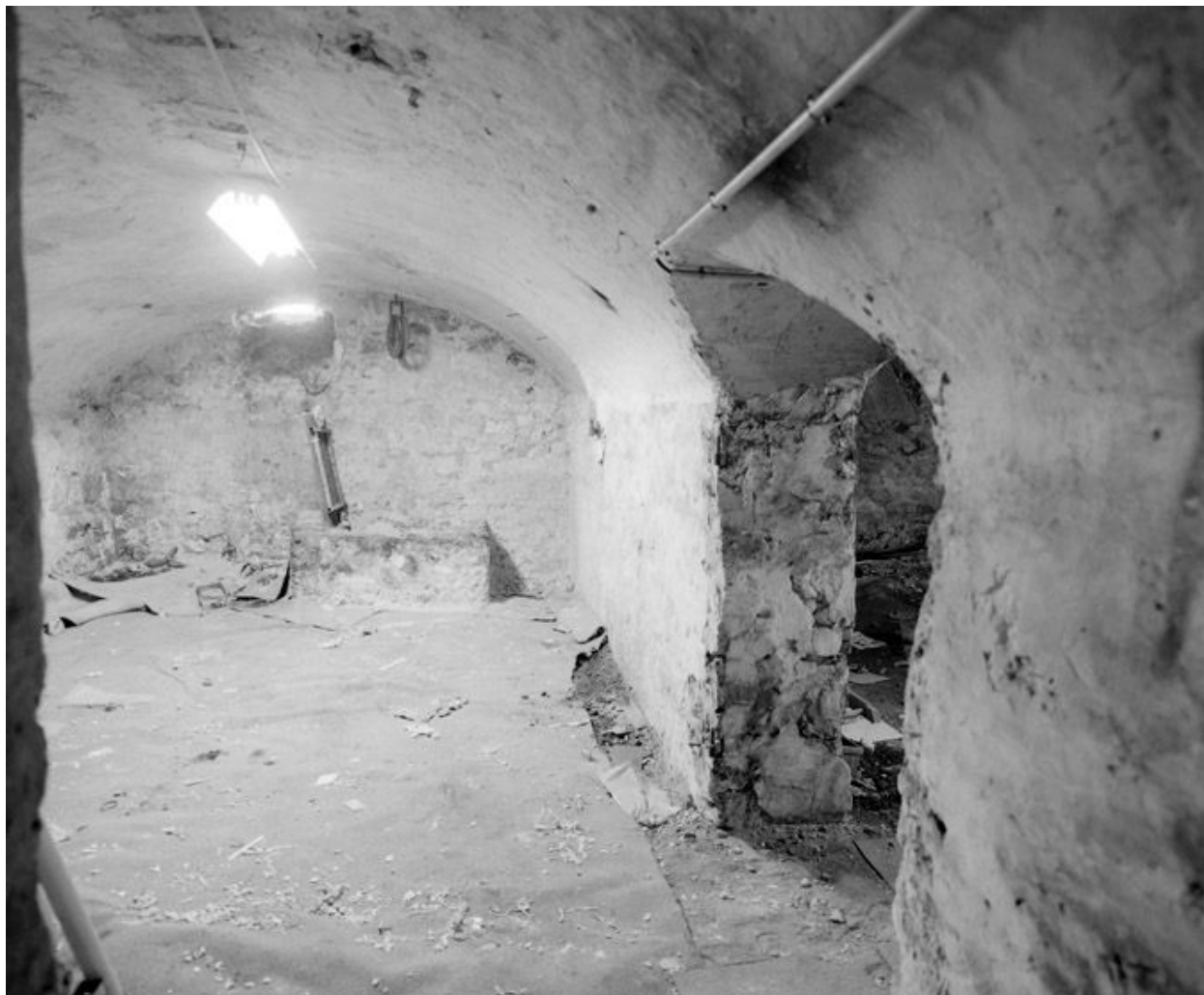
La cave : vue du berceau nord, avec au fond un puits carré.
