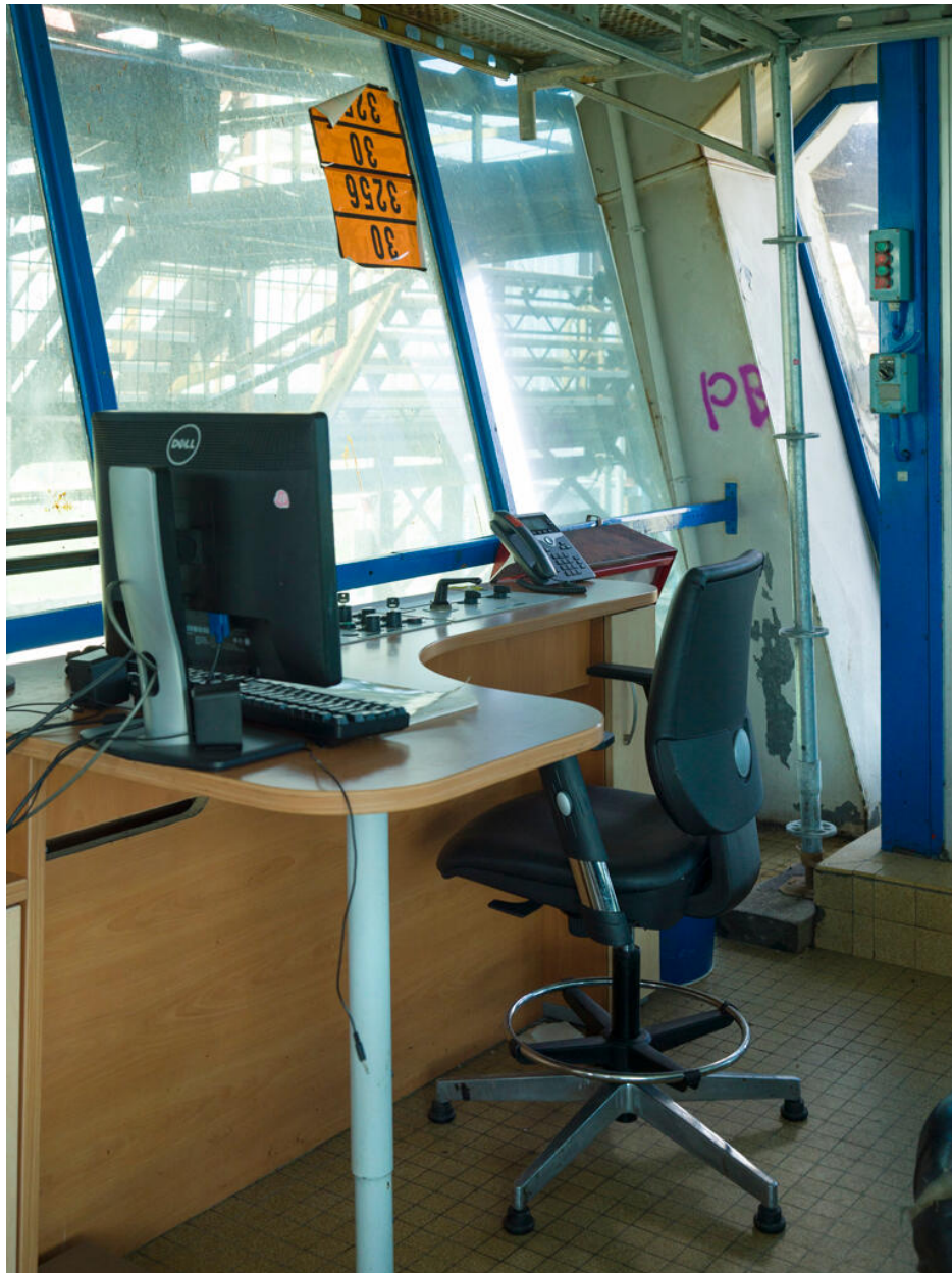
Chargement poste fer (Unité 540). Pupitre de commande poste fer.
