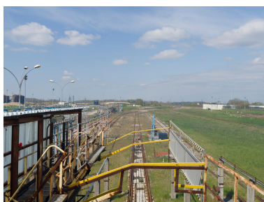
Chargement poste fer (Unité 540). Chargement fiouls lourds, gasoil et FOD (fioul domestique). Passerelle d'accès au toit des wagons avec à droite, son organe de sécurité ("panier"). Phot. Stéphane Asseline, Phot. Stéphane Asseline IVR11_20237700365NUC4A
