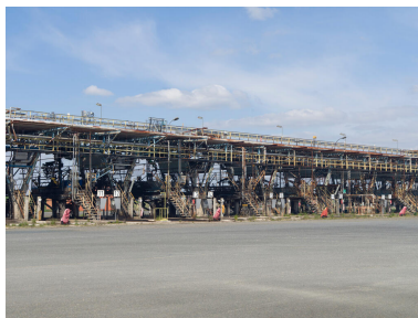
Quais de chargement route multiproduits (Unité 530). Phot. Stéphane Asseline, Phot. Stéphane Asseline IVR11_20237700359NUC4A
