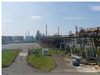
Quais de chargement route multiproduits (Unité 530). Phot. Stéphane Asseline, Phot. Stéphane Asseline IVR11_20237700358NUC4A
