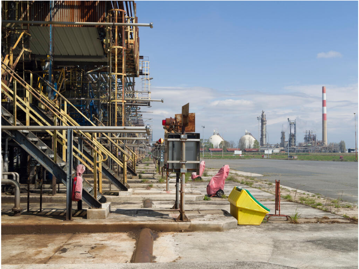
Quais de chargement route multiproduits (Unité 530). Entrée du quai de chargement.
