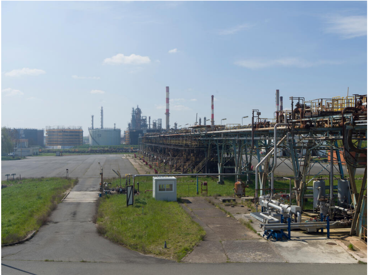
Quais de chargement route multiproduits (Unité 530).
