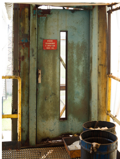
Chargement poste fer (Unité 540). Ancien ascenseur poste fer, inutilisé. Phot. Stéphane Asseline, Phot. Stéphane Asseline IVR11_20237700370NUC4A
