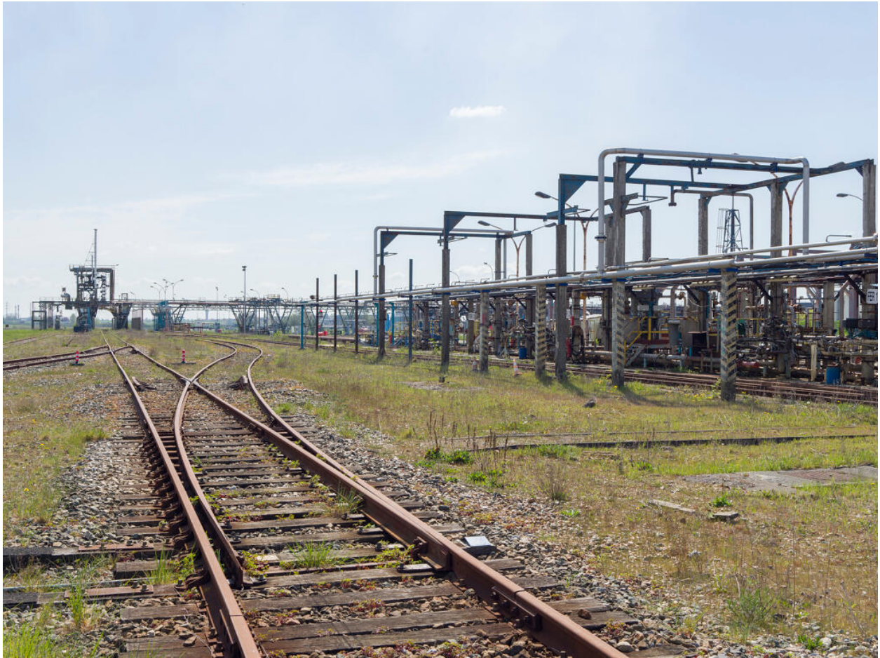
Voie ferrée expéditions, desservant poste fer et poste brut.
