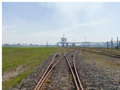
Voie ferrée expéditions. Aiguillage. Au fond, chargement fer. Phot. Stéphane Asseline, Phot. Stéphane Asseline IVR11_20237700391NUC4A
