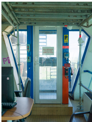
Chargement poste fer (Unité 540). Poste de commande. Derrière la porte, SAS d'entrée (local pressurisé). Une légère surpression suffit à empêcher la pénétration éventuelle des gaz, en cas de fuite. Phot. Stéphane Asseline, Phot. Stéphane Asseline IVR11_20237700367NUC4A
