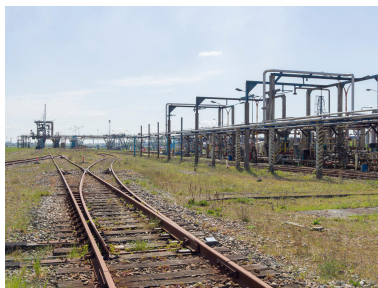
Voie ferrée expéditions, desservant poste fer et poste brut. Phot. Stéphane Asseline, Phot. Stéphane Asseline IVR11_20237700392NUC4A
