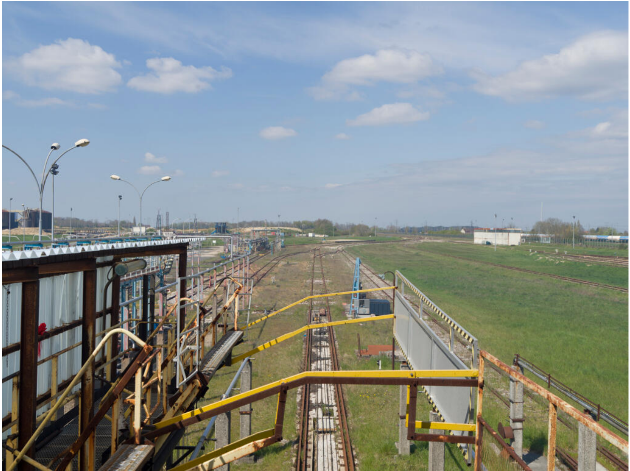
Chargement poste fer (Unité 540). Chargement fiouls lourds, gasoil et FOD (fioul domestique). Passerelle d'accès au toit des wagons avec à droite, son organe de sécurité ("panier").
