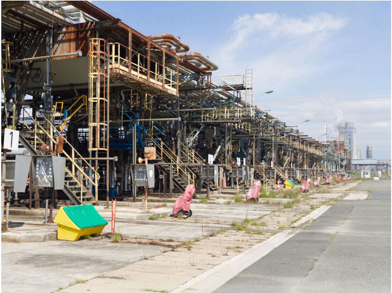
Quais de chargement route multiproduits (Unité 530).
