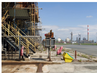
Quais de chargement route multiproduits (Unité 530). Entrée du quai de chargement. Phot. Stéphane Asseline, Phot. Stéphane Asseline IVR11_20237700361NUC4A
