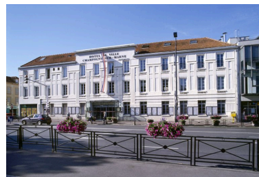
Vue générale de l'actuelle mairie, située juste en vis-à-vis de l'ancienne mairie qui accueille aujourd'hui les services techniques. A droite on distingue l'extension récente de Chemetov. Phot. Stéphane Asseline IVR11_20079400402XA
