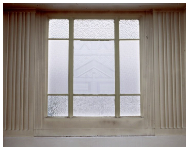
Détail des motifs gravés de la verrière du hall. Phot. Stéphane Asseline IVR11_20079400146XA
