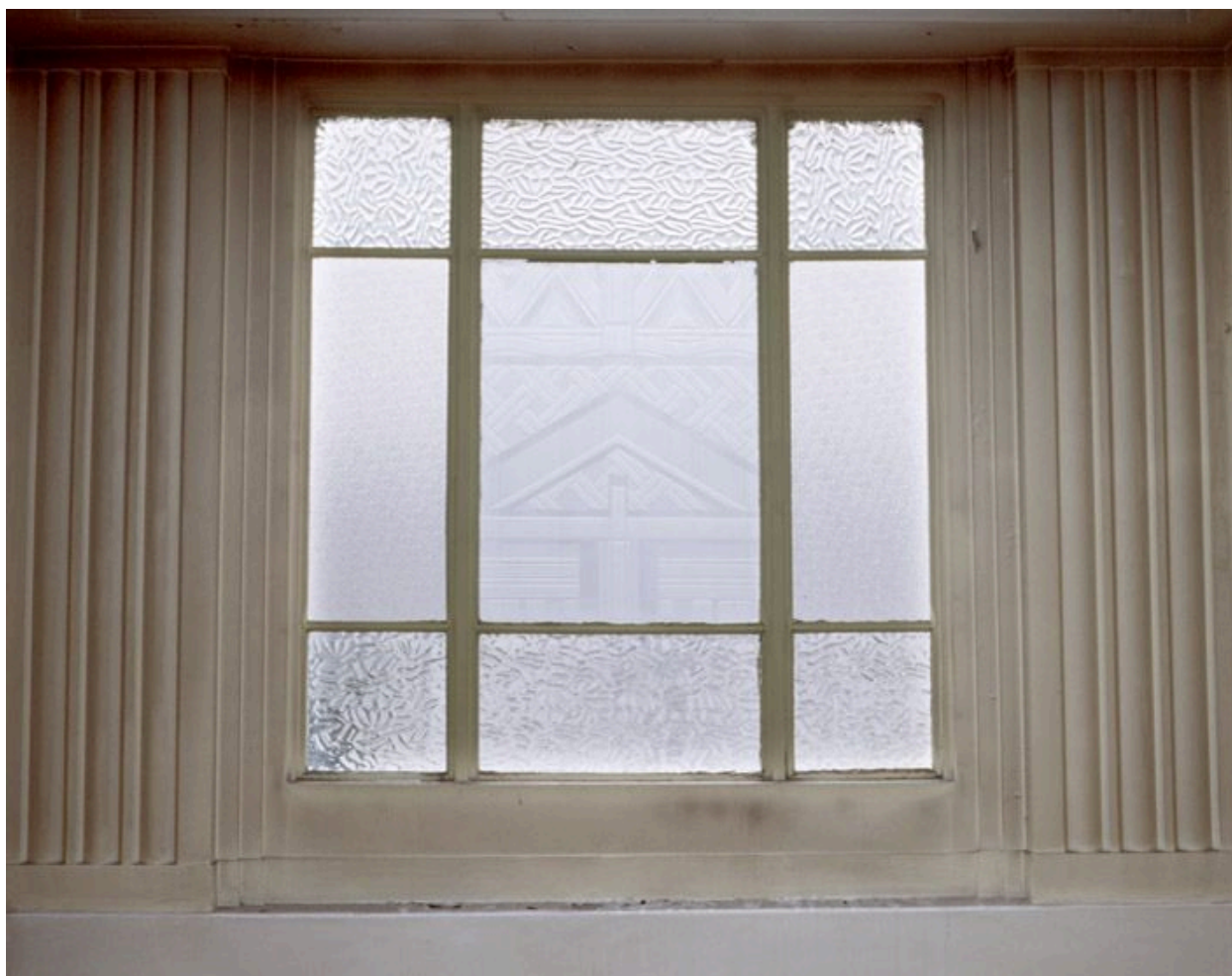
Détail des motifs gravés de la verrière du hall.
