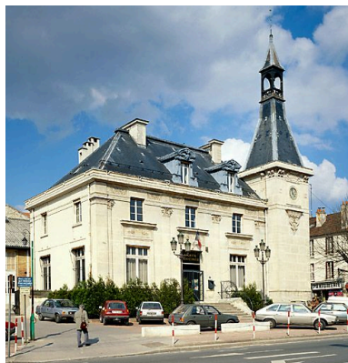
Façade antérieure. Phot. Christian Décamps IVR11_19869400142VA
