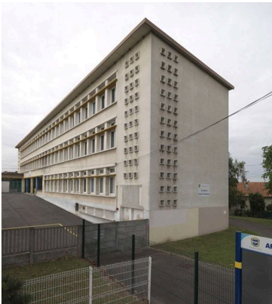
Un des bâtiments du groupe scolaire Edouard-Herriot, construit pour desservir la cité.
