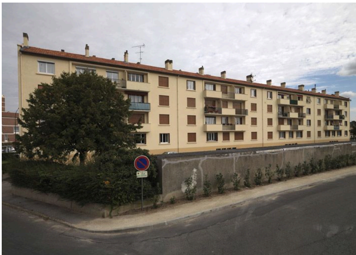
Façade arrière, sur la rue des Castors, de l'immeuble situé entre cette rue et celle du Commandant-Bouchet.
