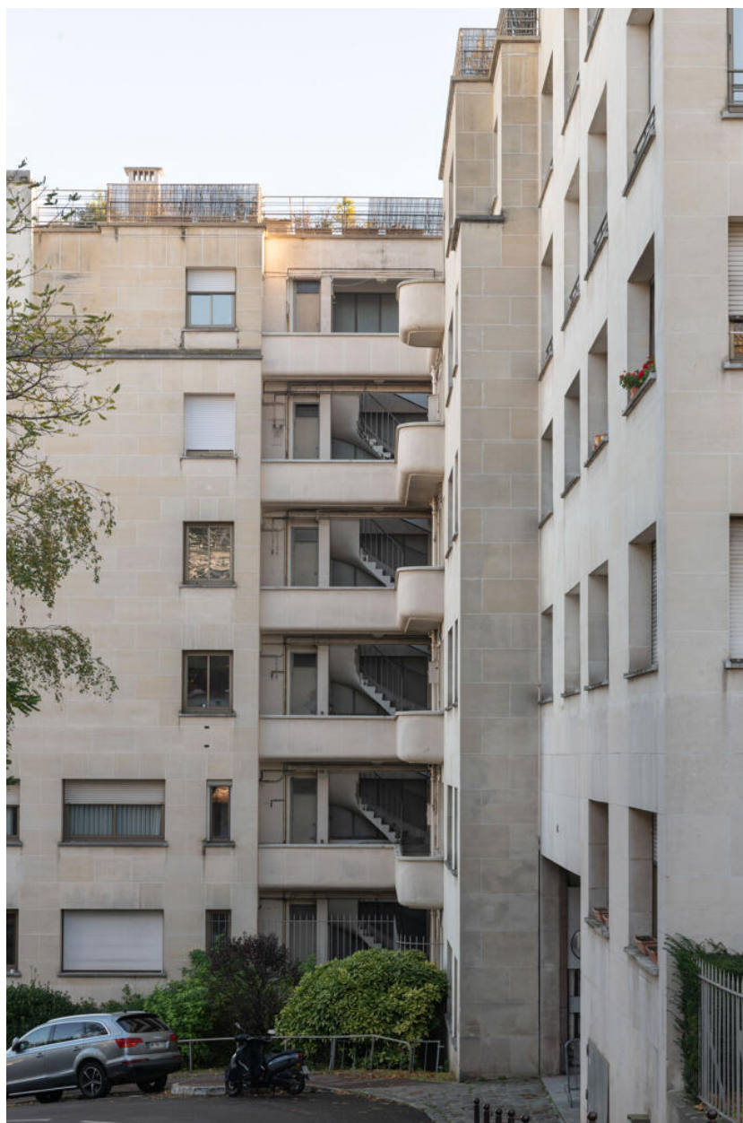
Ensemble des Gâte-Ceps, escalier de service
