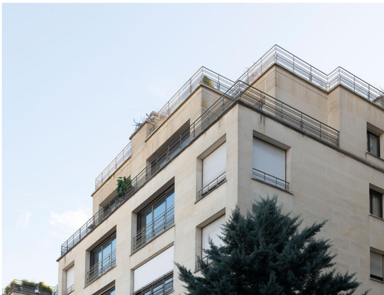
Ensemble des Gâte-Ceps, toits-terrasses et garde-corps style paquebot
