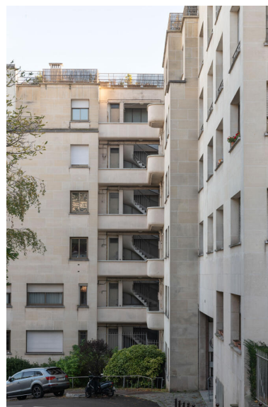
Ensemble des Gâte-Ceps, escalier de service Phot. Kruszyk Laurent IVR11_20249200910NUC4A
