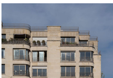
Ensemble des Gâte-Ceps, partie supérieure de l'aile nord : terrasses et garde-corps caractéristiques de l'architecture paquebot Phot. Kruszyk Laurent IVR11_20249200920NUC4A
