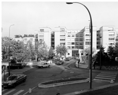
Ensemble des Gâte-Ceps, façade principale Phot. Ayrault Philippe IVR11_19969200980X
