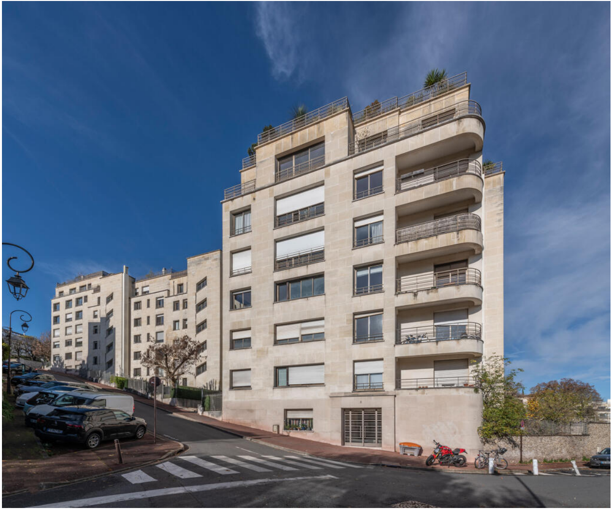
Ensemble des Gâte-Ceps, façade sud de l'aile sud
