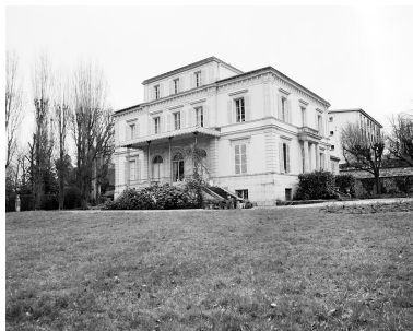
Façade sur le parc.
