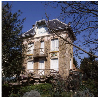
Vue d'ensemble. Phot. Philippe Ayrault IVR11_20089100530XA
