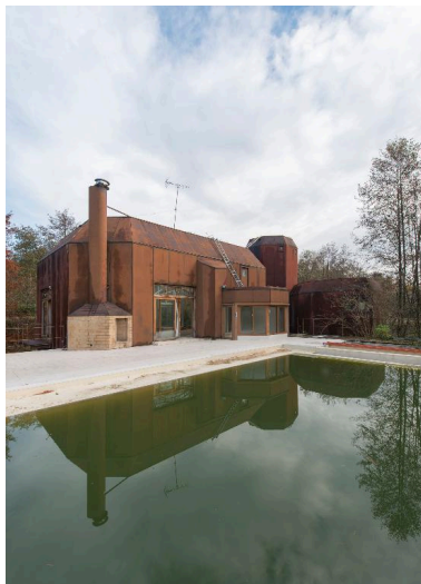
Vue de la façade sud et du bassin de la piscine Phot. Laurent Kruszyk IVR11_20179100166NUC4
