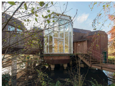
Vue de la façade nord, et de la passerelle d'accès à l'entrée principale Phot. Laurent Kruszyk IVR11_20179100165NUC4
