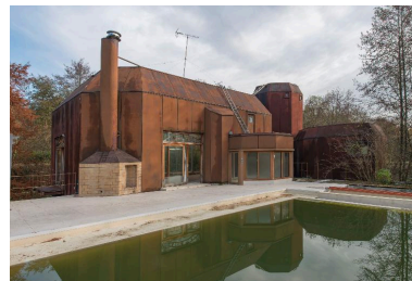
Vue rapprochée de la façade sud Phot. Laurent Kruszyk IVR11_20179100167NUC4
