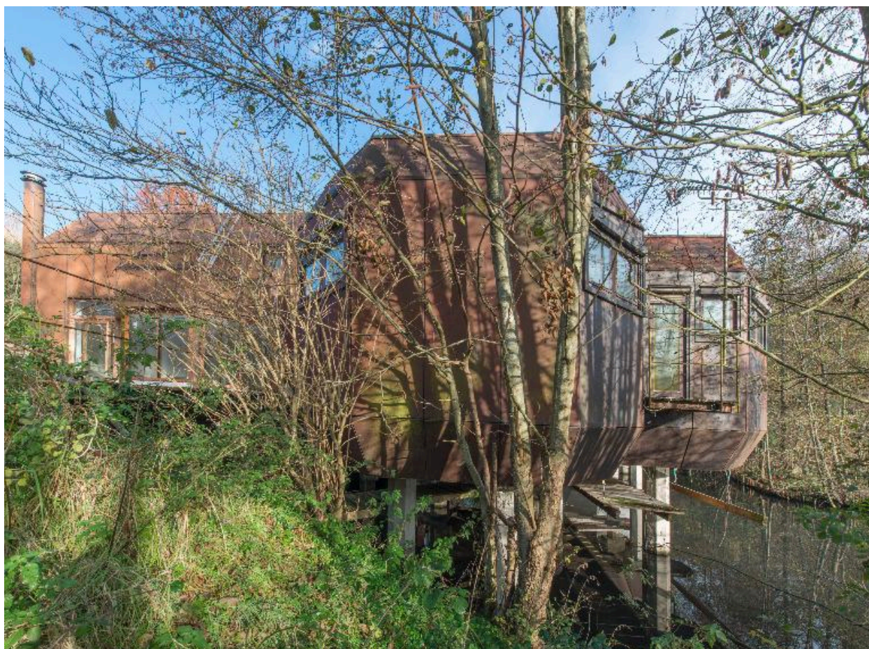
Vue des pavillons sur pilotis, côté sud
