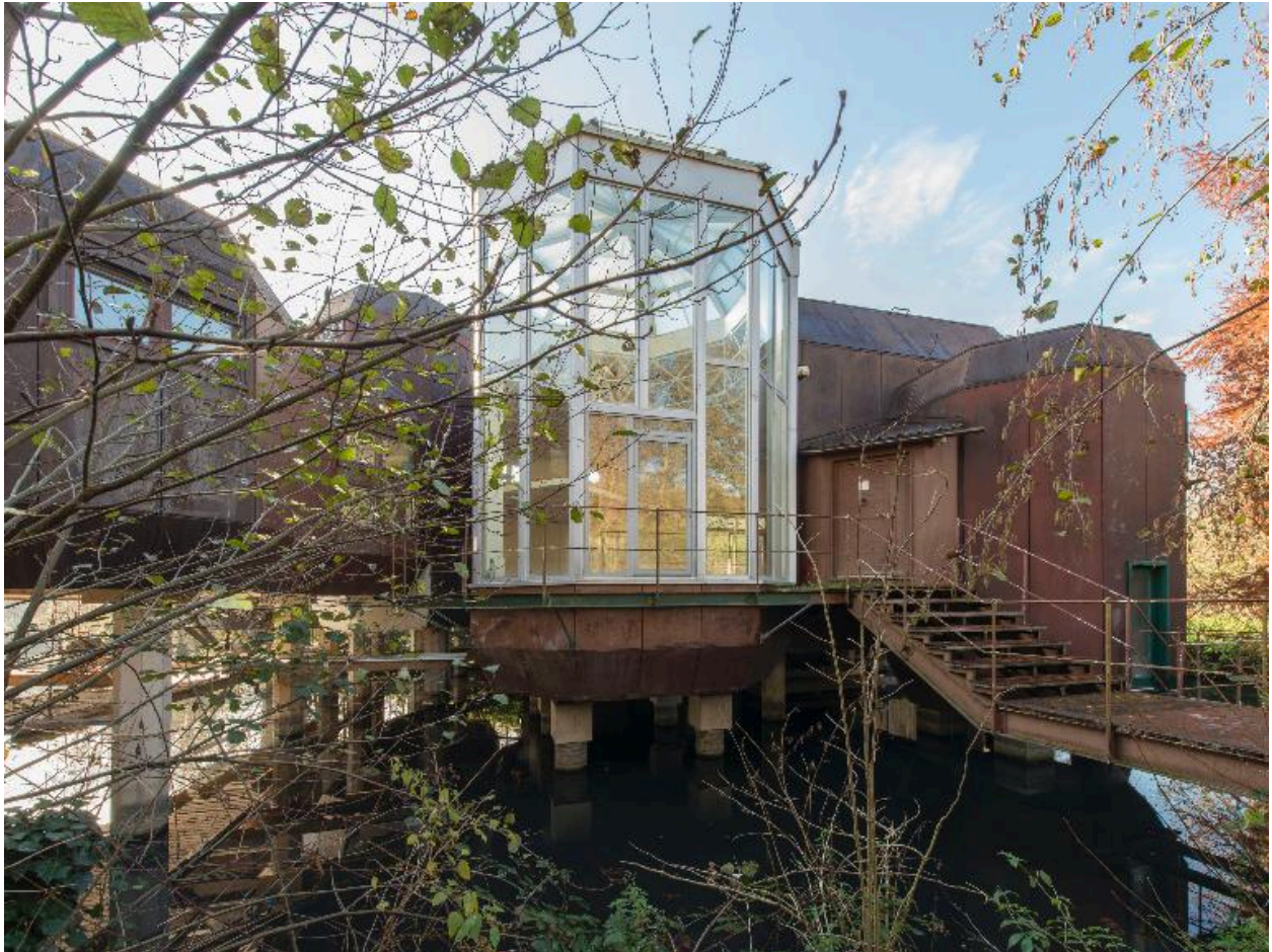
Vue de la façade nord, et de la passerelle d'accès à l'entrée principale
