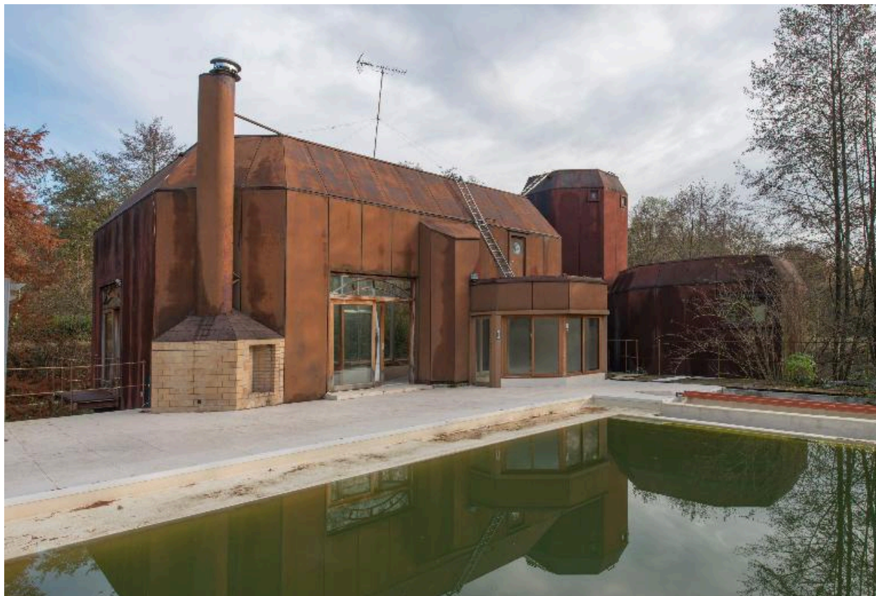
Vue rapprochée de la façade sud
