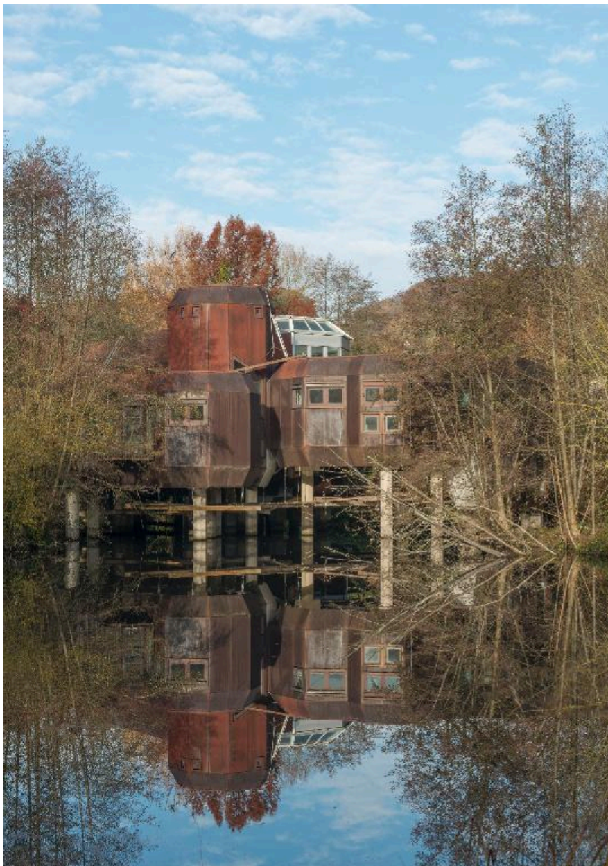
Vue des pavillons sur pilots, côté sud-est (1)
