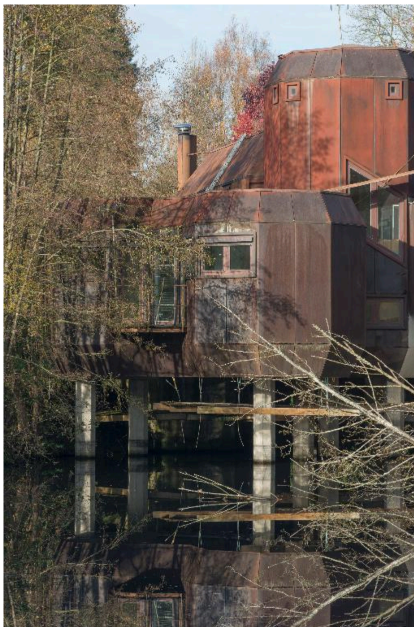
Vue des pavillons sur pilots côté sud-est (3)
