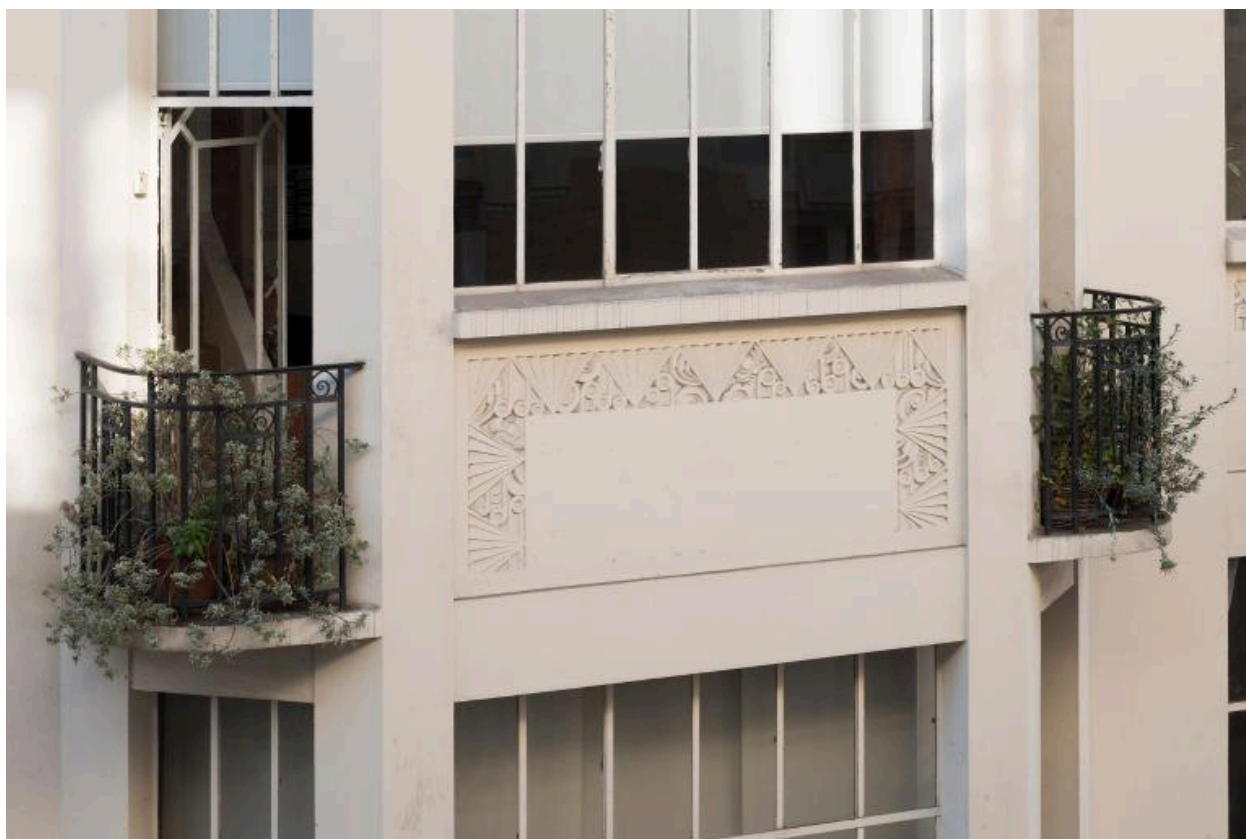
Détail de la frise décorative et des balconnets du deuxième étage de la façade sur rue
