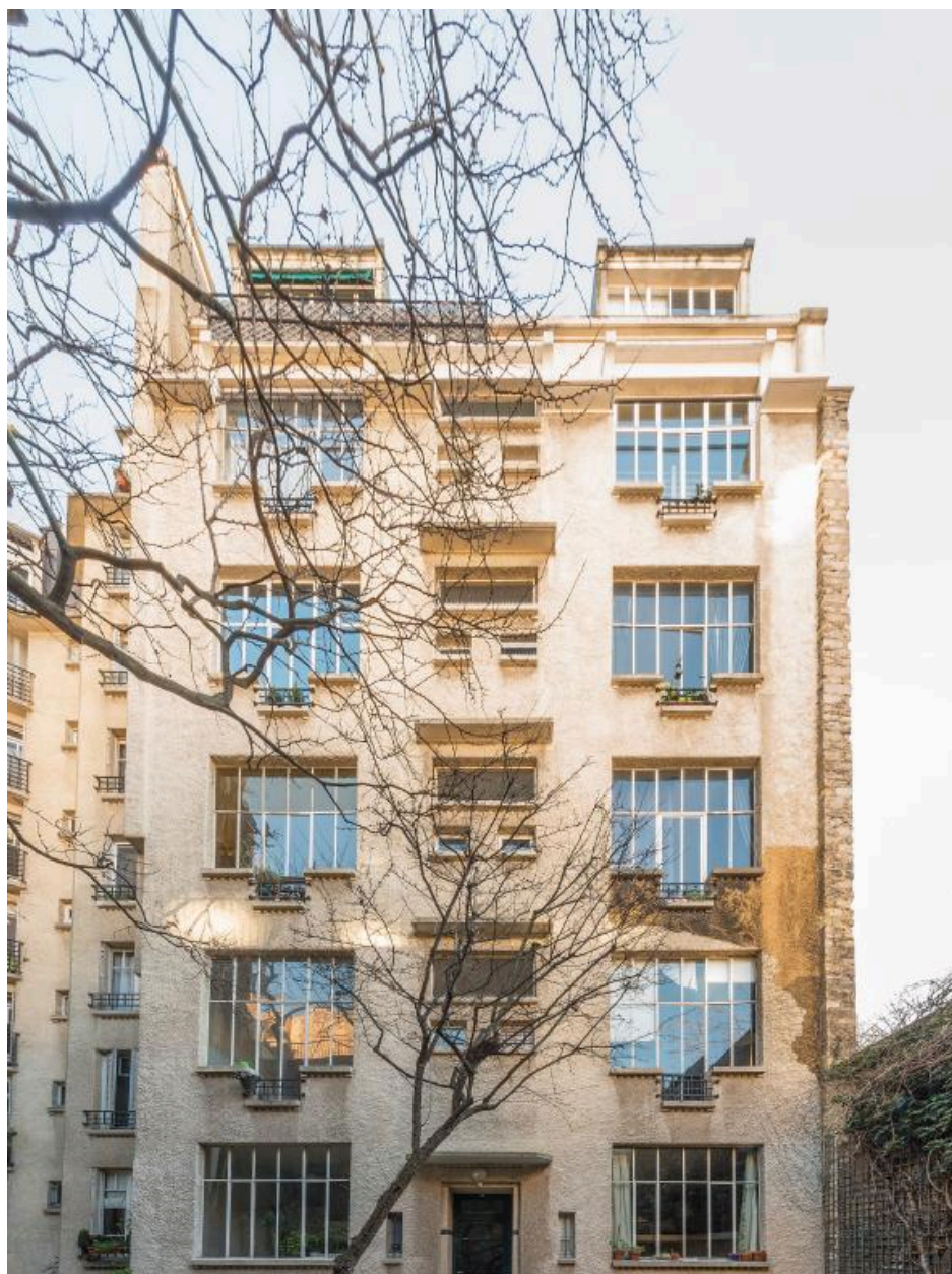
Vue de la façade de l'immeuble sur cour, depuis la cour
