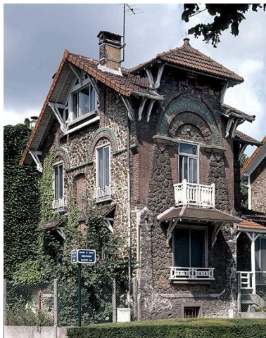
Vue d'ensemble. Phot. Stéphane Asseline IVR11_20049400324VA
