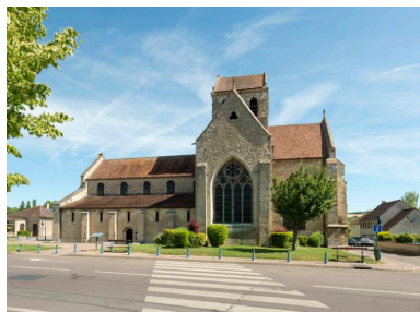
Vue de la façade méridionale. Phot. Laurent Kruszyk IVR11_20177800725NUC4A
