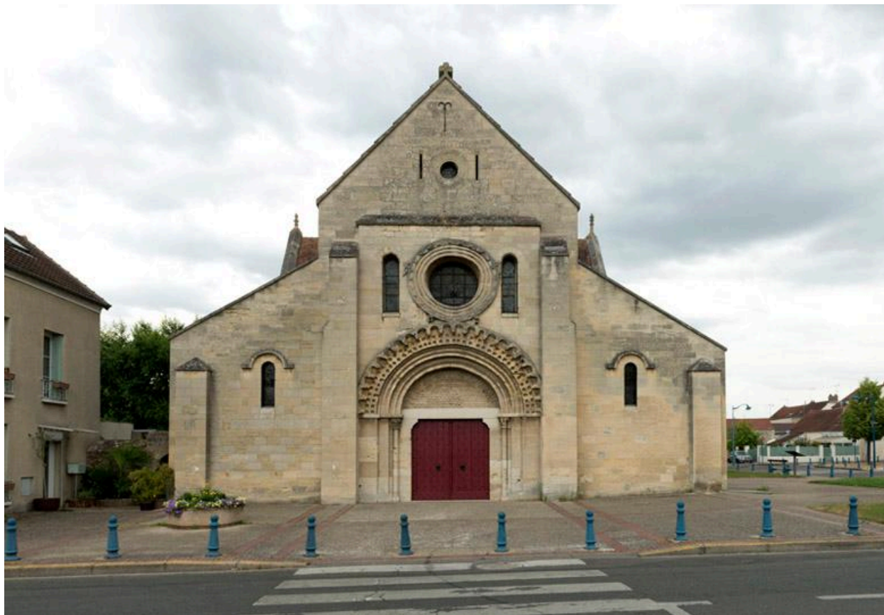
Vue de la façade occidentale.
