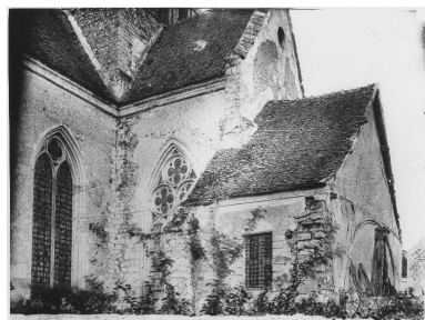
Vue du bas-côté nord avant restauration. (Fonds CREDOP). IVR11_20177801508NUC4
