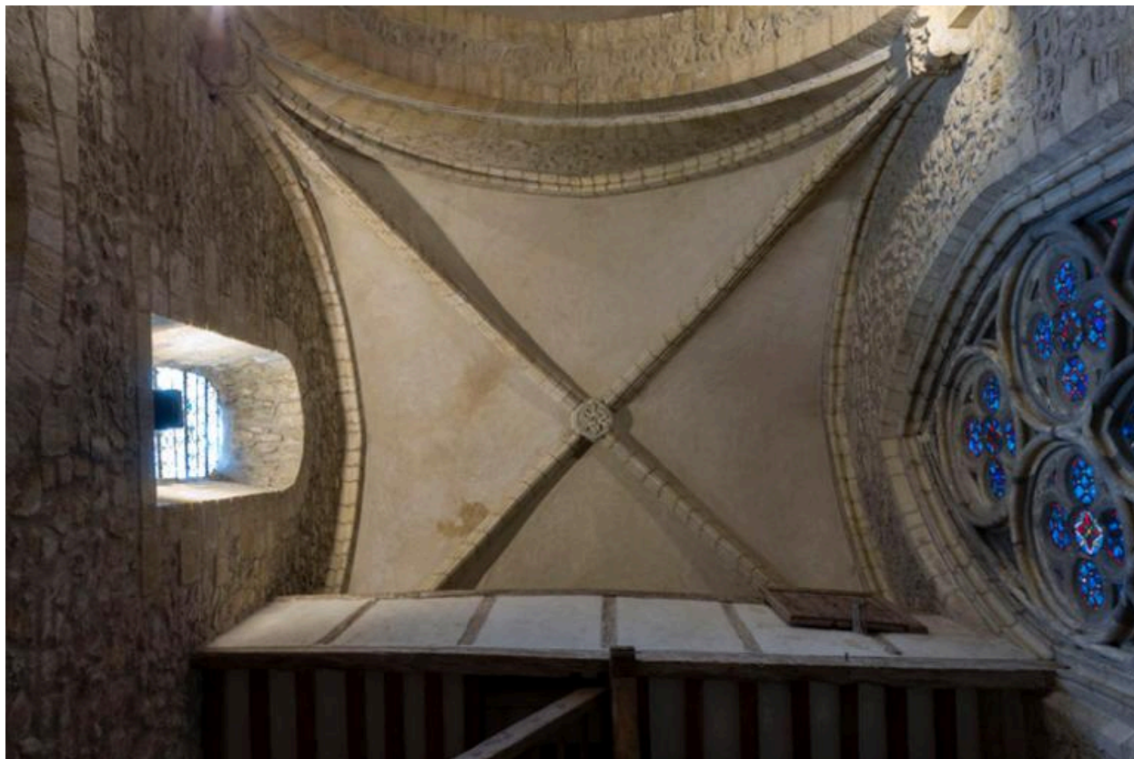
La voûte du bras nord du transept. On aperçoit la galerie en surplomb qui permet d'accéder au clocher.
