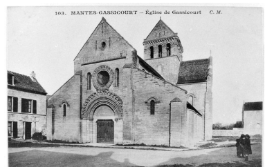
Vue d'ensemble de l'église. Carte postale (Région Île de France. Fonds CREDOP). Repro. CREDOP IVR11_20157800066X
