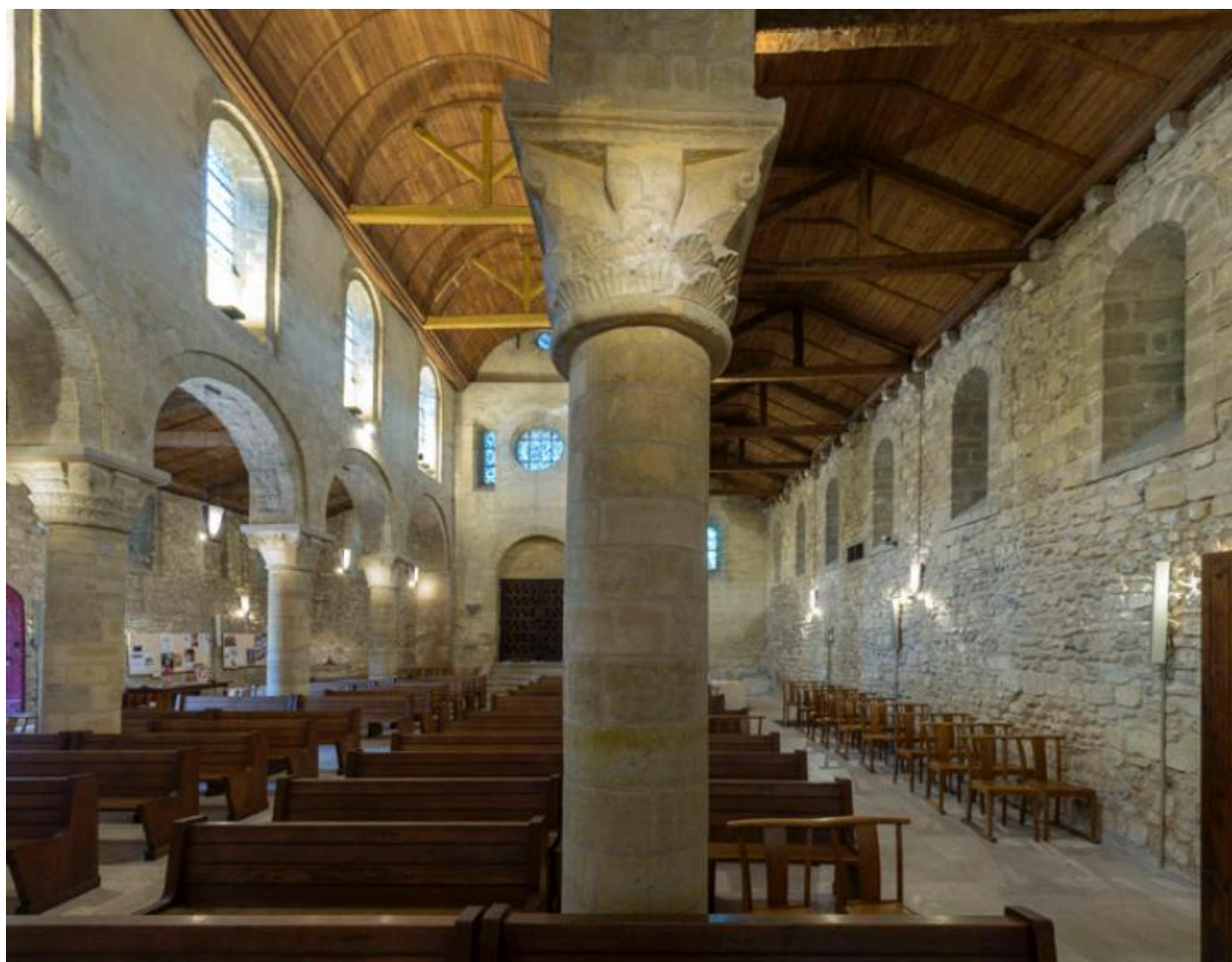
Vue du bas-côté sud dont la charpente est elle-aussi une restitution récente.
