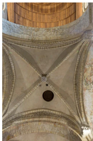
La voûte de la croisée du transept. Phot. Laurent Kruszyk IVR11_20177800757NUC4A
