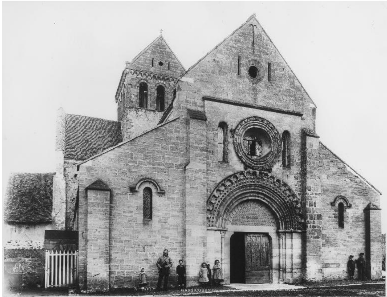
Vue de l'église après dégagement des bâtiments qui la jouxtaient. (Fonds CREDOP)
