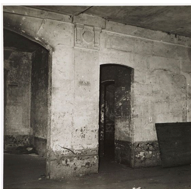
Photographie des anciens bâtiments de l'abbaye Notre-Dame du Marché, reconvertie en quartier de cavalerie, avant démolition : vue intérieure. Photographie, vers 1965. (Médiathèque Luxembourg, Meaux. Fonds Endrès ) IVR11_20137700433NUC4A
