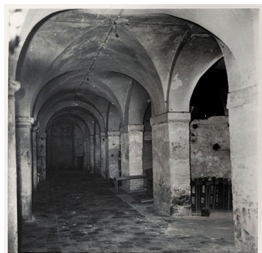
Photographie des anciens bâtiments de l'abbaye Notre-Dame du Marché, reconvertie en quartier de cavalerie, avant démolition : vue intérieure. Photographie, vers 1965. (Médiathèque Luxembourg, Meaux. Fonds Endrès ) IVR11_20137700434NUC4A
