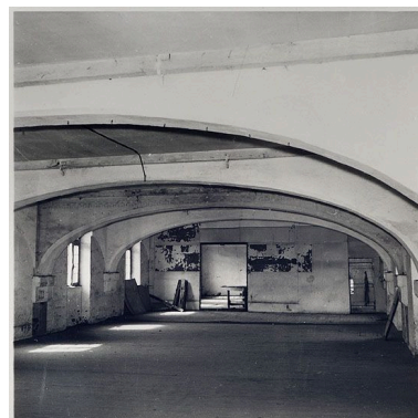
Photographie des anciens bâtiments de l'abbaye Notre-Dame du Marché, reconvertie en quartier de cavalerie, avant démolition : vue intérieure du dortoir. Photographie, vers 1965. (Médiathèque Luxembourg, Meaux. Fonds Endrès ) IVR11_20137700442NUC4A
