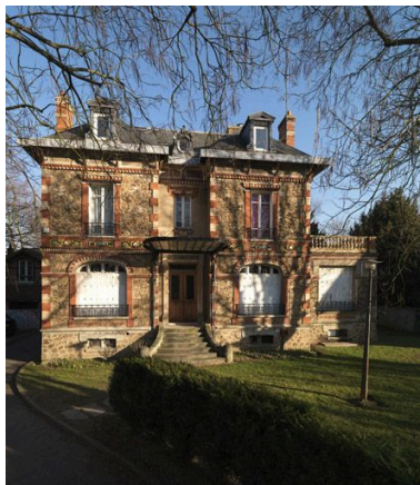
Vue d'ensemble. Phot. Philippe Ayrault IVR11_20089100206NUC4A
