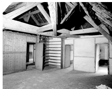
Vue des combles. Phot. Stéphane Asseline IVR11_20027700710X
