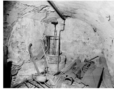
Puits dans la cave. Phot. Stéphane Asseline IVR11_20027700719X
