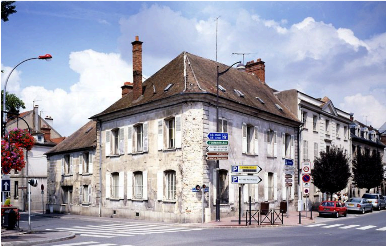
Vue d'ensemble, depuis le sud-est (façades sur le boulevard Gambetta et le quai Alsace-Lorraine).
