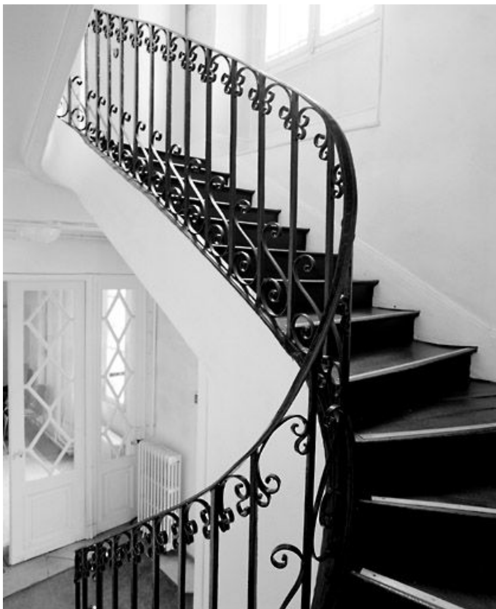
Vue de l'escalier.
