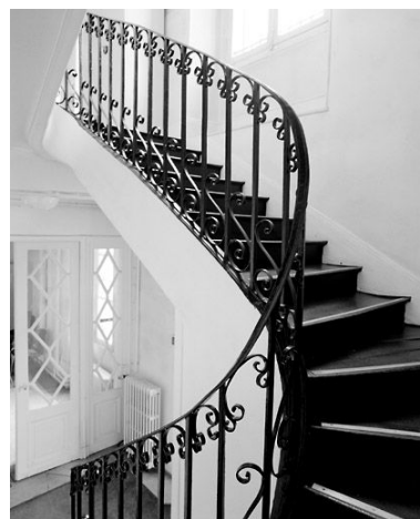
Vue de l'escalier. Phot. Stéphane Asseline IVR11_20027700715X
