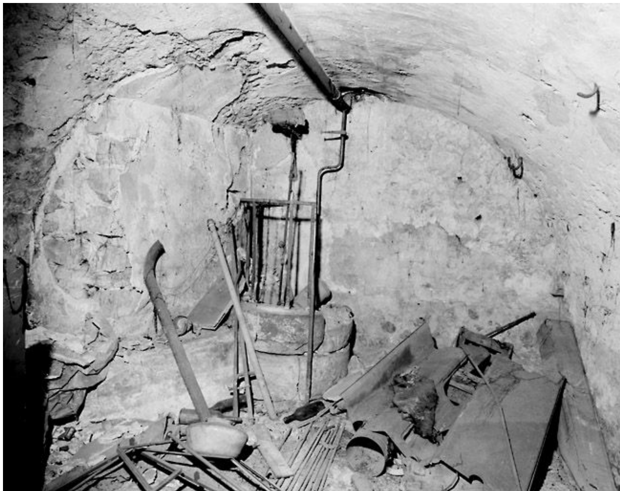
Puits dans la cave.
