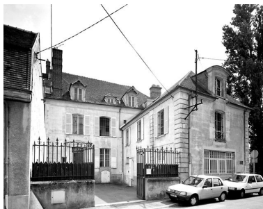
Vue d'ensemble, depuis l'ouest. Phot. Stéphane Asseline IVR11_20027700721V
