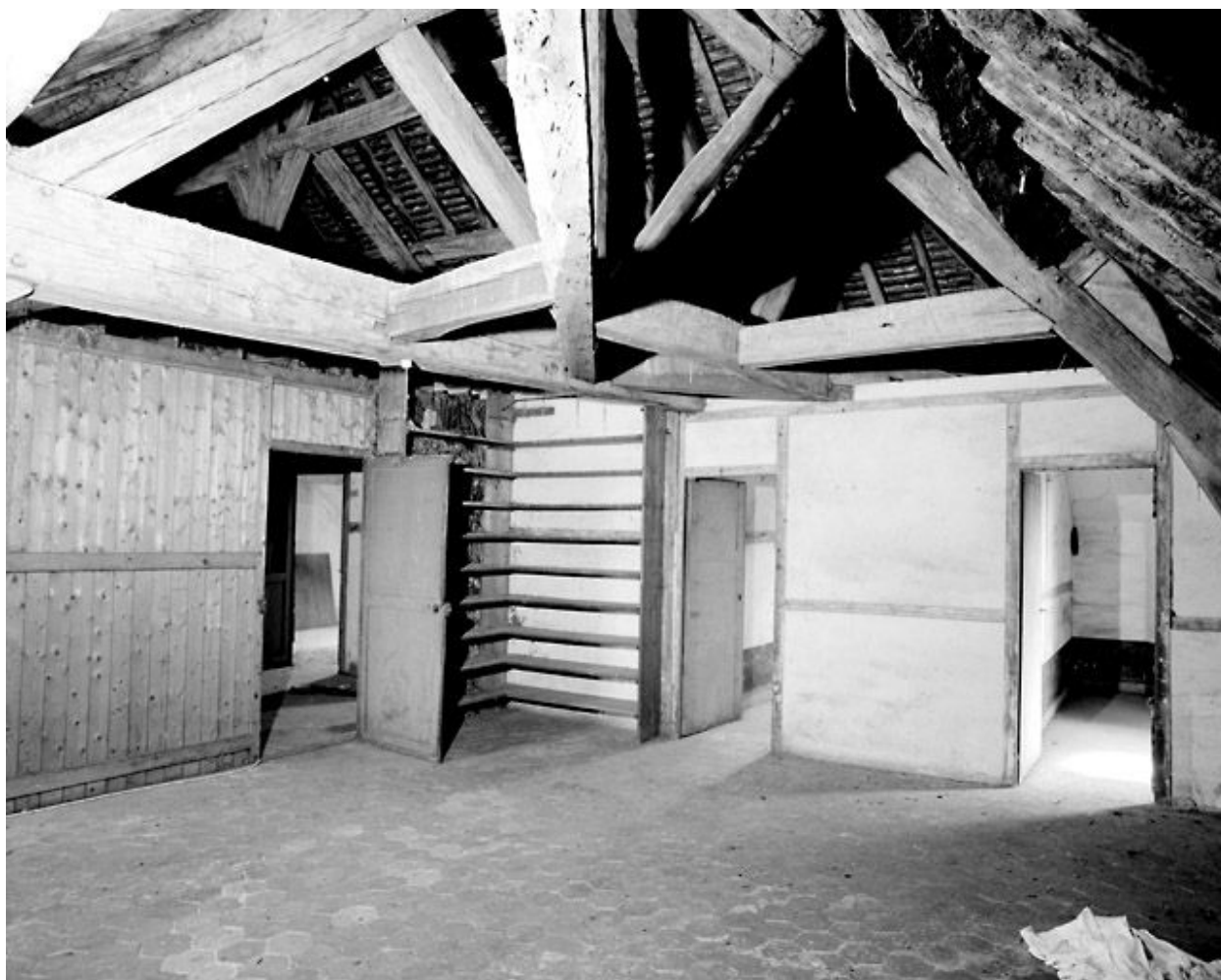
Vue des combles.
