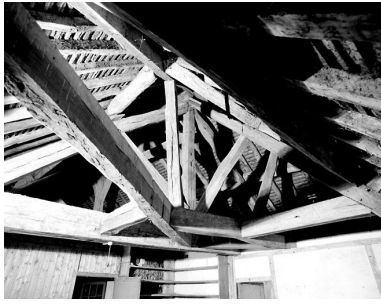
Vue de la charpente, à l'angle sud du corps de logis. Phot. Stéphane Asseline IVR11_20027700711X
