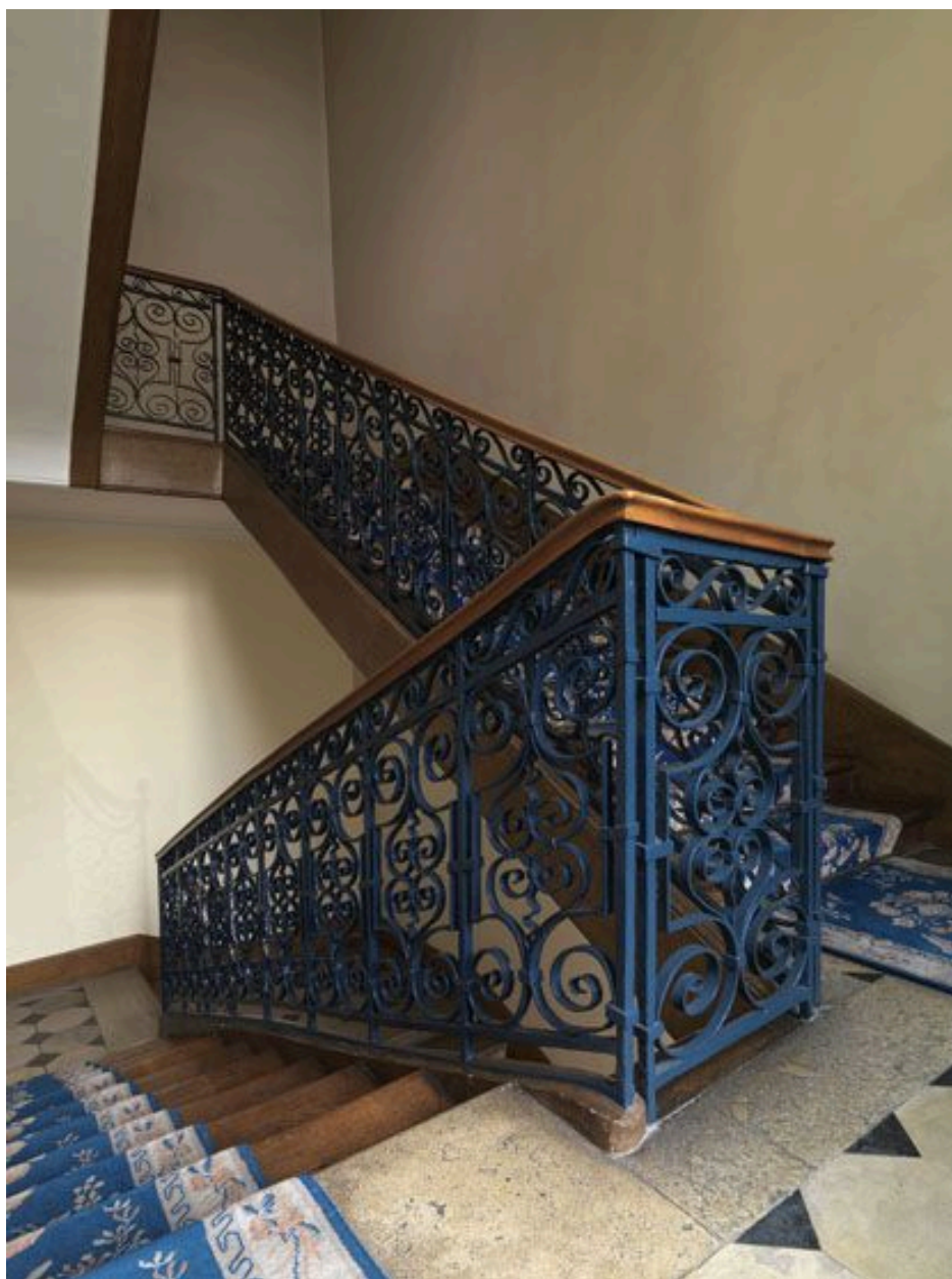
Vue d'ensemble de l'escalier à partir du premier étage.
