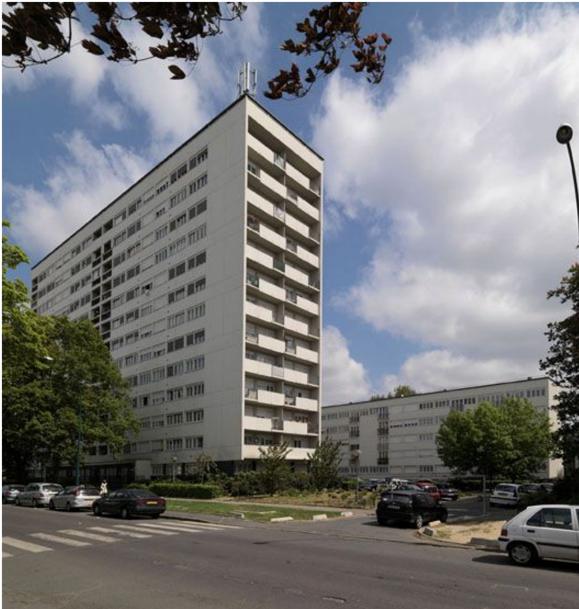
La barre B : façade principale et pignon.
