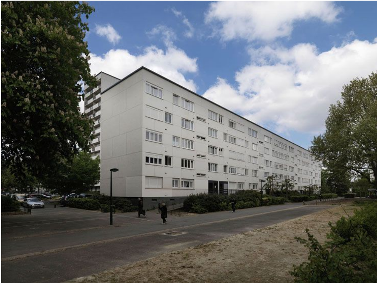
La barre C réhabilitée.
