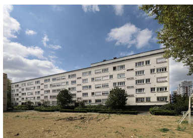
façade arrière de la barre H. Phot. Jean-Bernard Vialles IVR11_20109100086NUC4A
