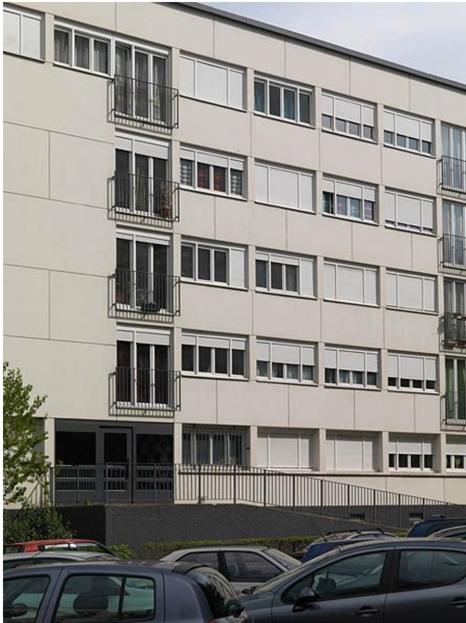
Façade principale orientée côté parking et rampes d'accès. L'accès au hall d'entrée surélevé a été réhabilité en 2004 grâce à un financement Palulos.
