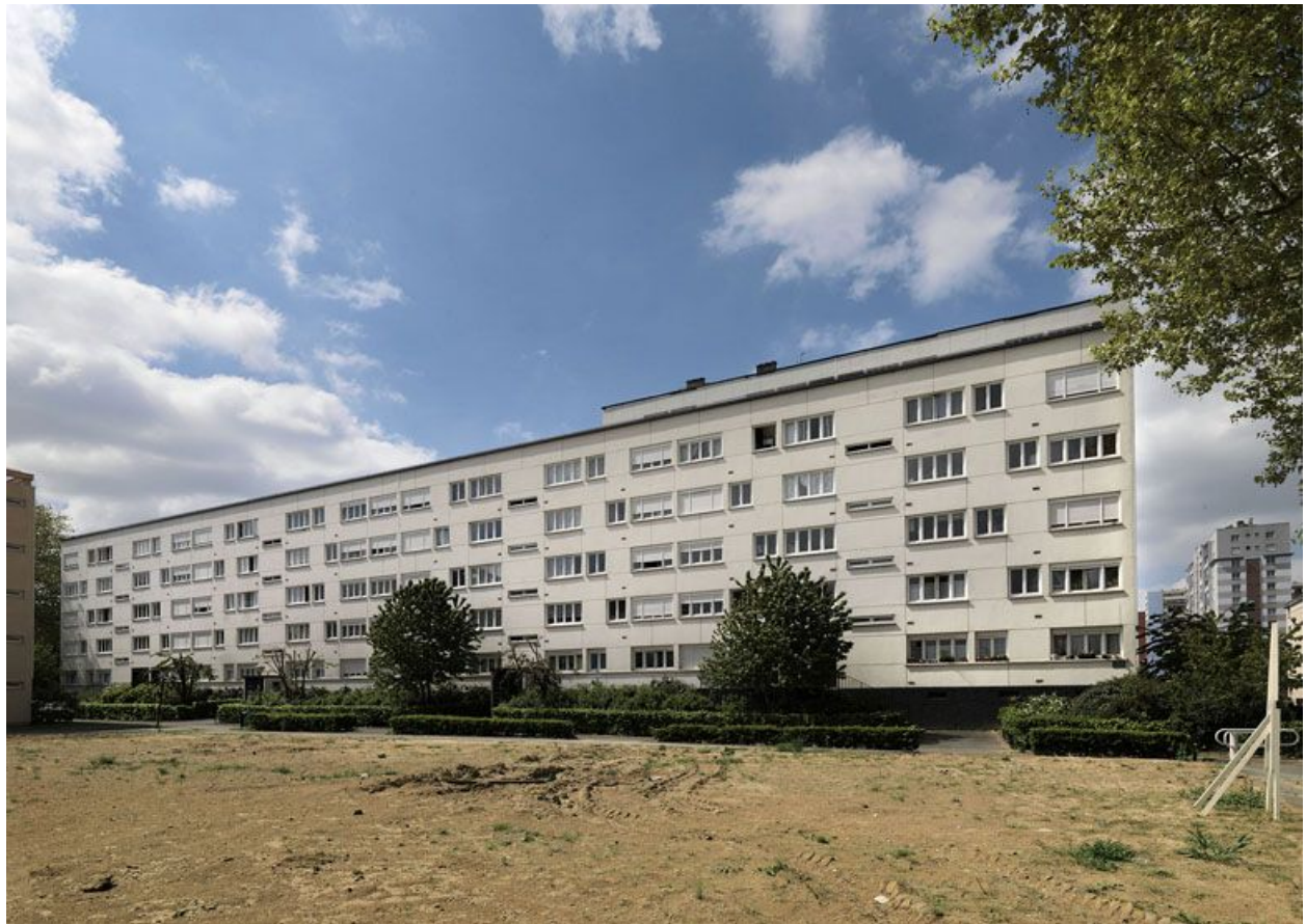
façade arrière de la barre H.
